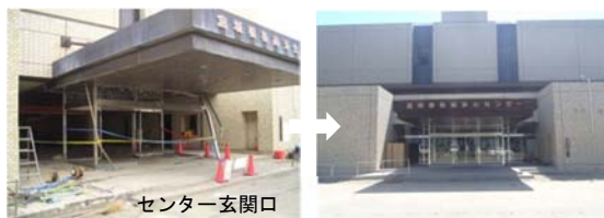
汚泥燃料化施設の復旧
