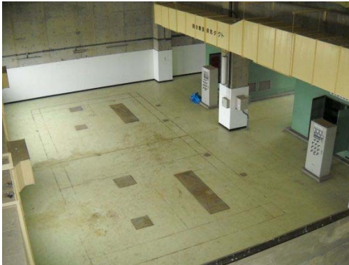
▲新電気室施工前
