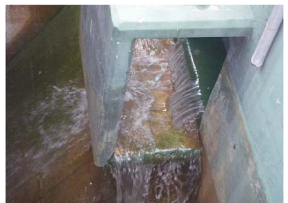
▲最初沈殿池 通水開始状況
