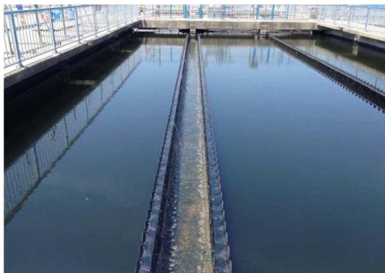
▲第4系列最終沈殿池復旧・処理状況
