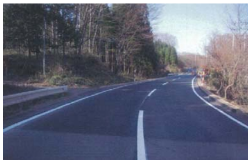
▲(主)蔵王川崎線(蔵王町円田②)復旧後
