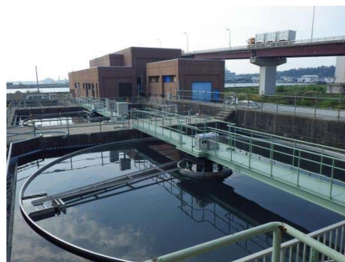
▲水張り完了状況
