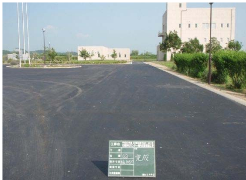
▲石越浄化センター復旧後
