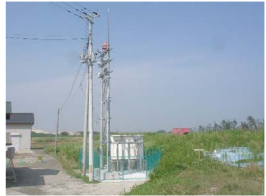
▲寺野警報所 復旧完了 サイレン塔は2柱式
