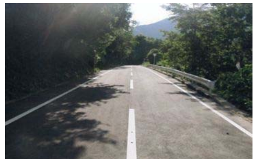
▲（主）南蔵王七ヶ宿線（七ヶ宿町柏木山②）復旧後
