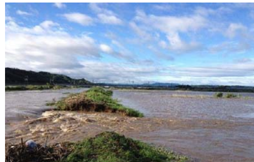
▲新川の堤防決壊(右岸)状況
