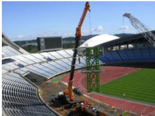
仮説柱の施工状況
