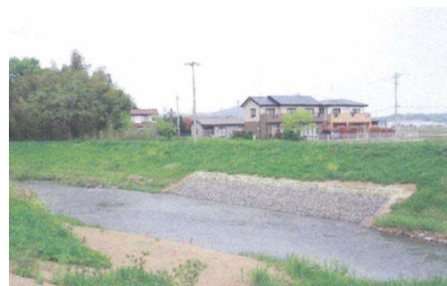
▲齋川(白石市大平板谷①)復旧後
