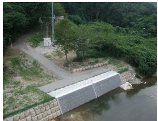
▲白沢河川水位観測所 復旧完了 新たに約70m上流右岸に設置
