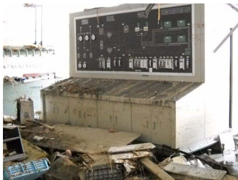
▲監視装置施工前
