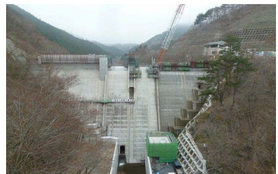
▲下流からのダム全景
