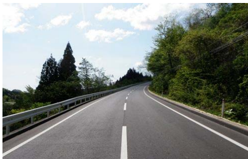
▲(国)457号 (川崎町本砂金①) 復旧後
