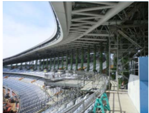
仮説柱の施工状況
