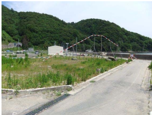
▲丁張りの設置
