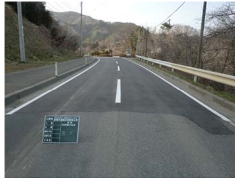
▲本復旧工事完了後
