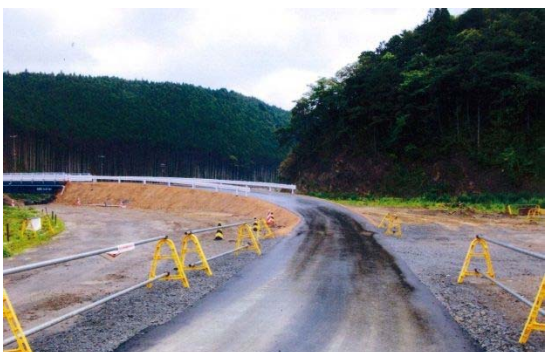
▲西戸橋復旧後
