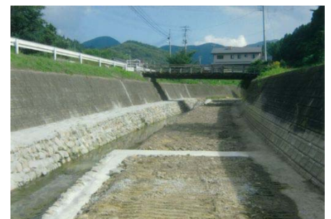
▲砂防流路改良工事
