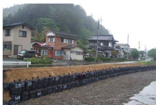
▲応急復旧完了（5月28日）
