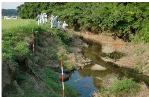
▲災害査定状況
