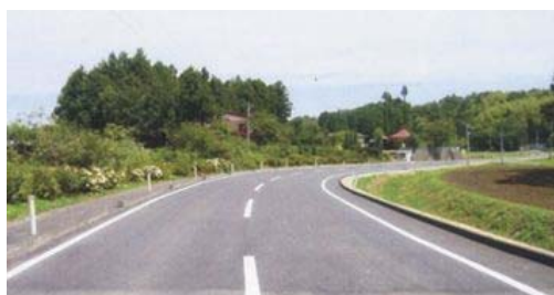
▲（主）丸森柴田線（丸森町小斎京壇）復旧後
