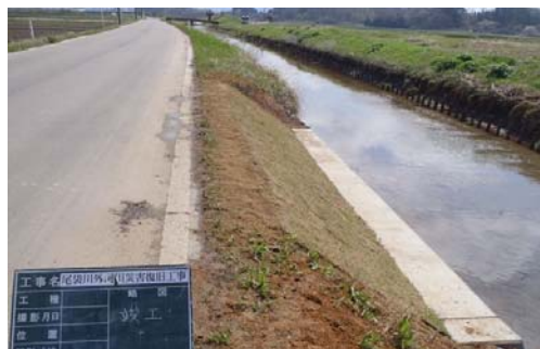
▲尾袋川（角田市小田）復旧後
