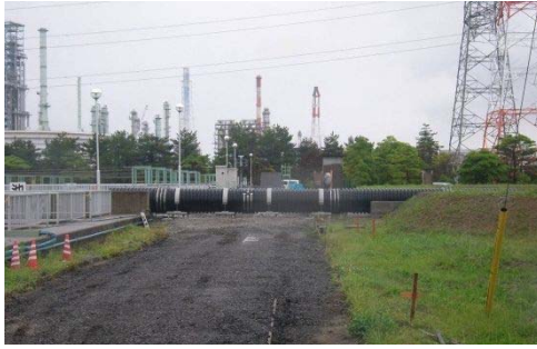
▲バイパス管接続状況
