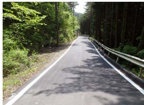
▲本復旧工事完了後
