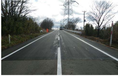
▲(国)457号(白石市福岡深谷即安)復旧後
