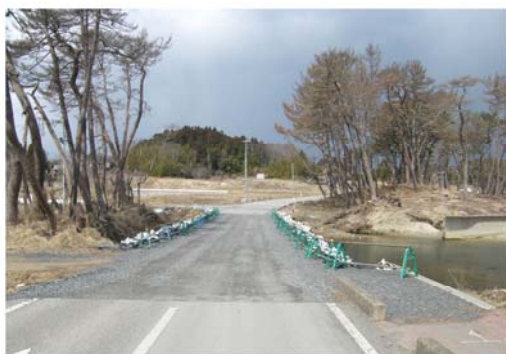
▲災害復旧応急工事完了後
