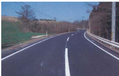
▲(主)蔵王川崎線(蔵王町円田①)復旧後
