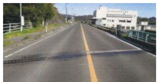
▲(国)349号(角田市江尻巻向)復旧後
