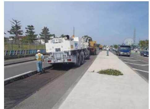
▲ふ頭5号線路面切削
