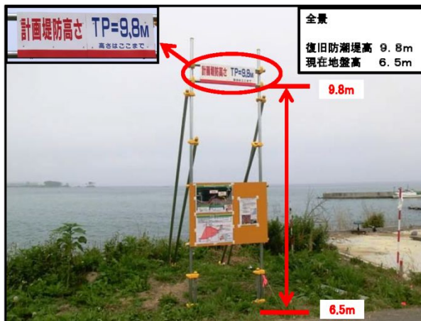
▲復旧高さ標示様子
