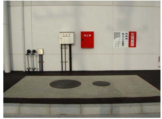
▲オイルタンク完成
