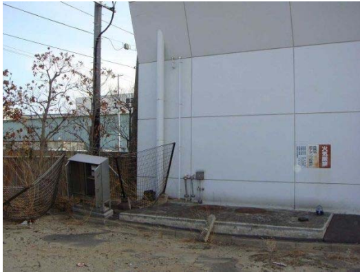
▲オイルタンク着工前
