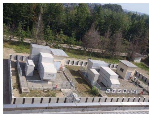
▲浸水対策完了
