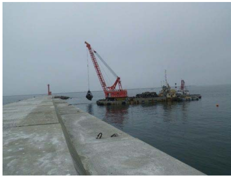
▲新北防波堤被覆石撤去
