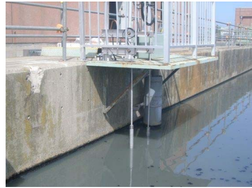
▲放流水質測定装置設置状況
