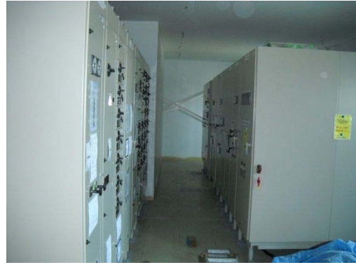
▲機器設置完了
