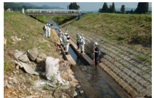
▲災害査定状況
