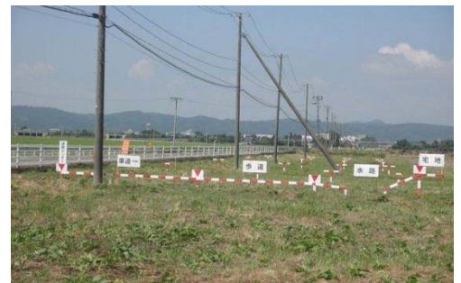
▲（一）岩沼海浜緑地線・道路計画の丁張り設置
