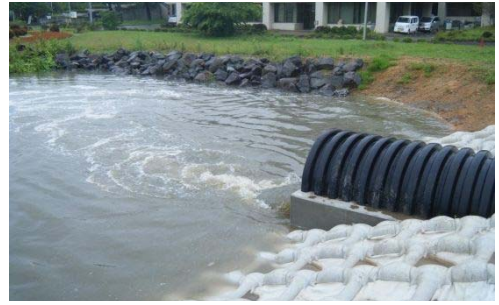
▲バイパス水路使用状況 「平成 24 年 7 月 7 日 大雨時」
