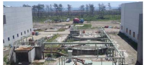
▲重力濃縮槽全3槽復旧完了
