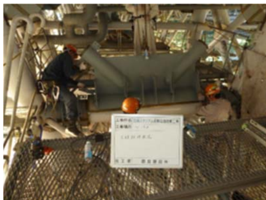
屋根T型梁の補強状況
