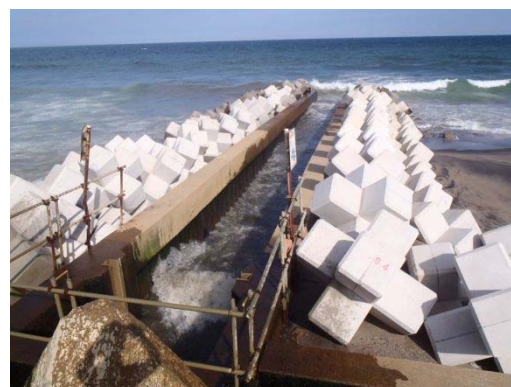
▲放流渠復旧状況
