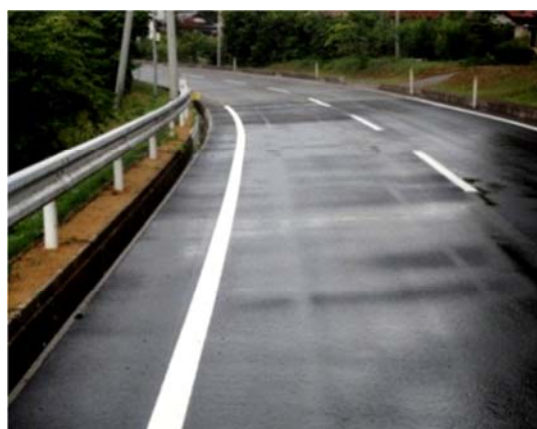
▲本復旧工事完了後
