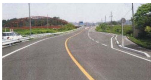
▲(国)349号(角田市江尻深沼)復旧後
