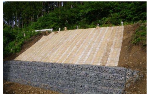
▲本復旧工事完了後
