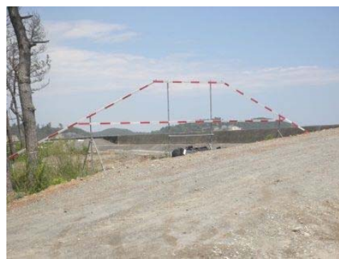
▲堤防計画の丁張り設置
