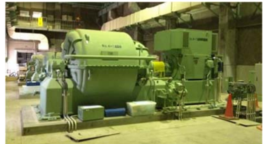
▲送風機設備復旧完了
