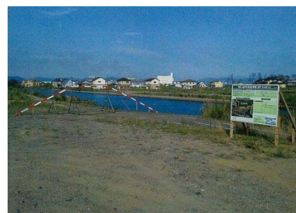
▲看板及び丁張り設置(8/10)
