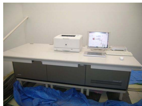
▲監視装置施工後
