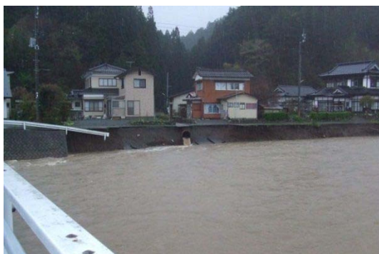
▲被災状況（5月4日）
