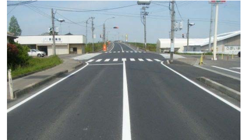
▲石巻鹿島台大衡線二郷外道路
