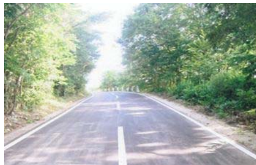
▲（主）南蔵王七ヶ宿線（七ヶ宿町柏木山①）復旧後
