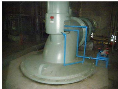
▲5号ポンプ復旧完了
