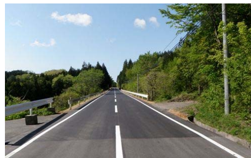
▲(国)457号 (川崎町本砂金②) 復旧後
