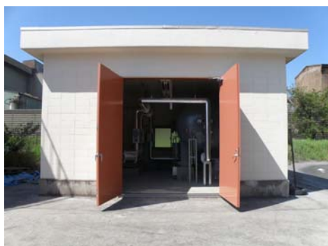
▲給水タンク復旧
