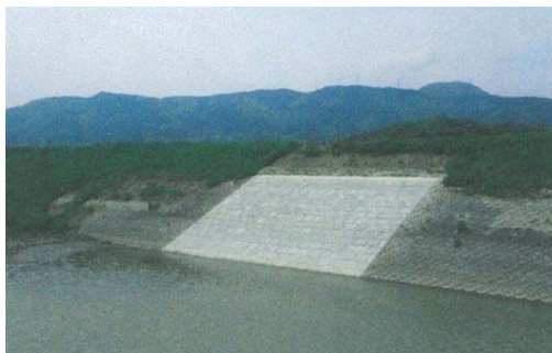
▲齋川(白石市大平森合)復旧後
