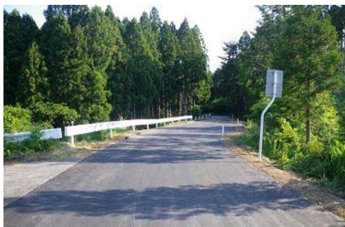
▲本復旧工事完了後
