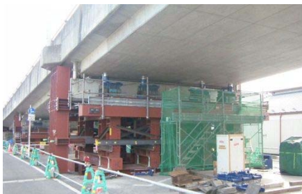
▲3径間に移動用支保工・ベントを設置
