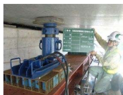
▲鉛直用 200ton ジャッキ
