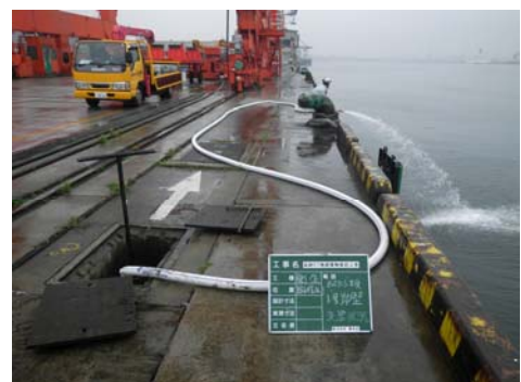
▲給水管の洗浄状況
