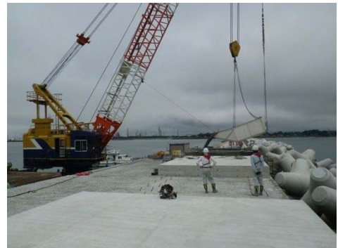
▲新北防波堤上部コンクリート打設
