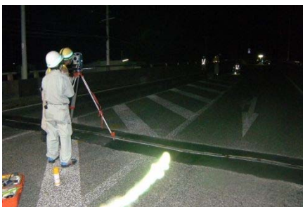
▲道路法線の確認
