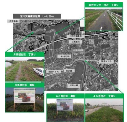
▲看板及び丁張り設置 (7/10)
