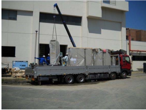
▲機器搬入状況
