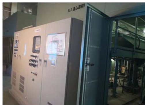
▲機械濃縮設備復旧完了
