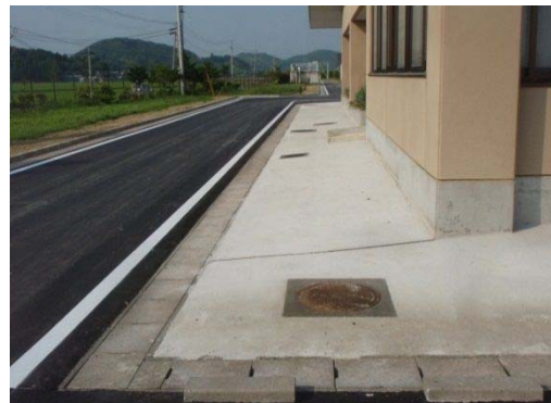
▲石越浄化センター復旧後
