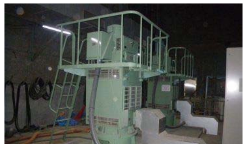
▲ポンプ設備全5台復旧完了
