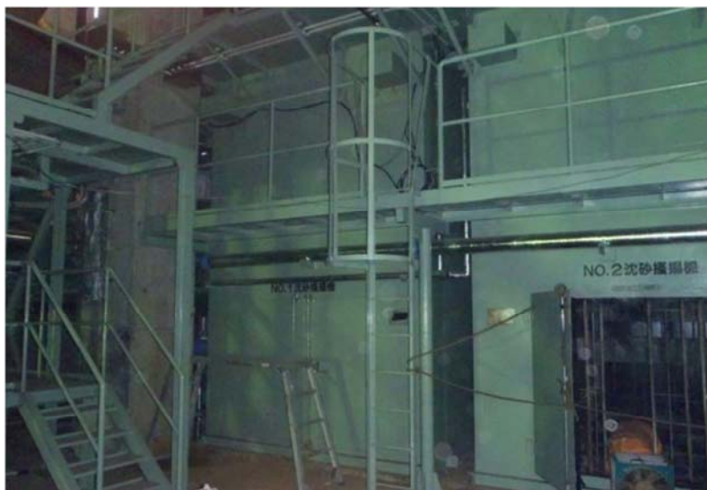
▲沈砂池設備沈砂掻揚機復旧状況
