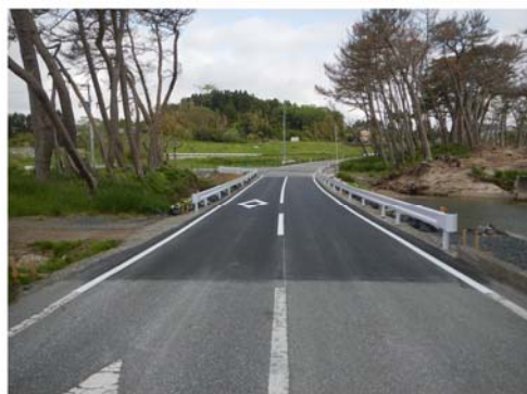
▲仮舗装工事完了後
