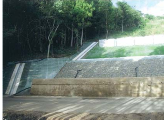
▲平成24年9月25日 本復旧完了
