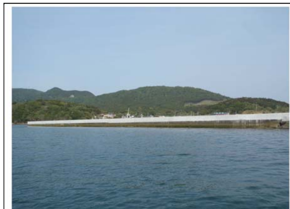
平成24年6月29日 本復旧完了
