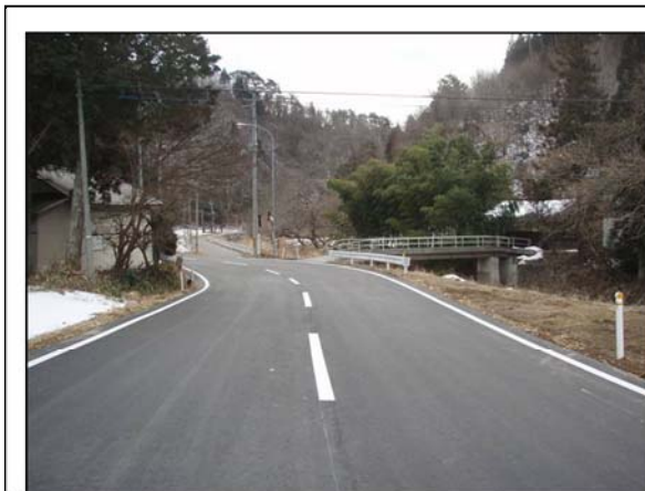
▲平成25年2月9日 本復旧完了
