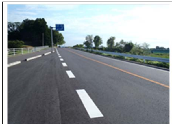
▲平成 24 年 5 月 22 日 本復旧完了
