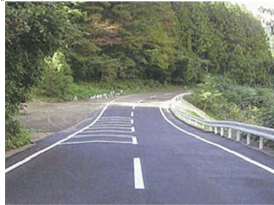
▲平成24年10月12日 本復旧完了
