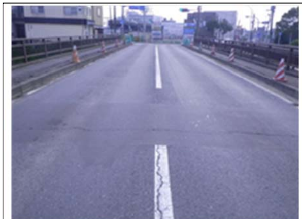
▲平成 24 年 5 月 23 日 復旧完了
