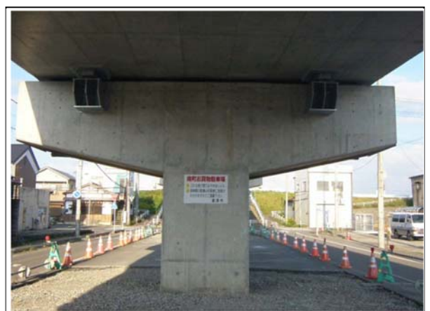
▲平成 24 年 11 月 13 日 本復旧完了
