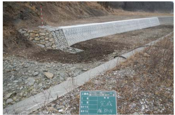
平成25年1月15日 本復旧完了
