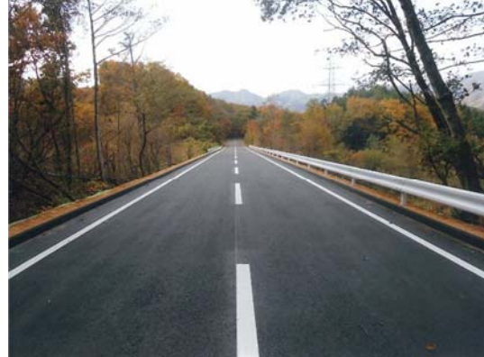
▲平成24年11月2日 本復旧完了
