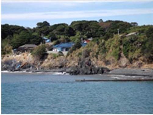
長渡海岸応急工事(その1) 被災状況
