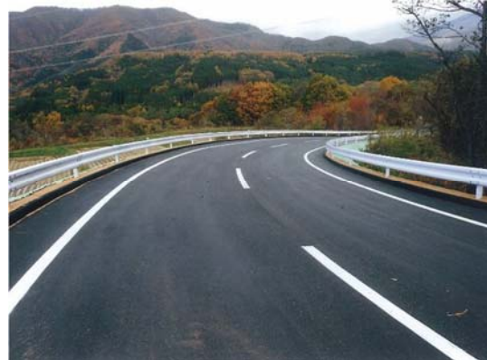
▲平成24年11月2日 本復旧完了
