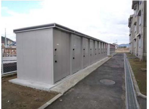
▲平成 24 年 12 月 20 日 本復旧完了
