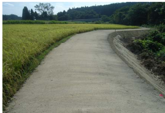
平成24年10月2日 本復旧完了
