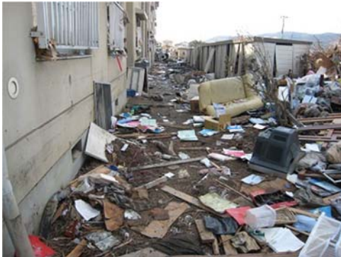
県営石巻黄金浜住宅団地 団地被災状況
