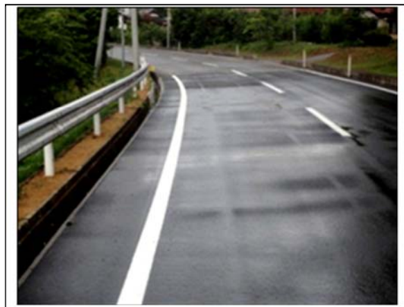
▲平成24年8月28日 本復旧完了
