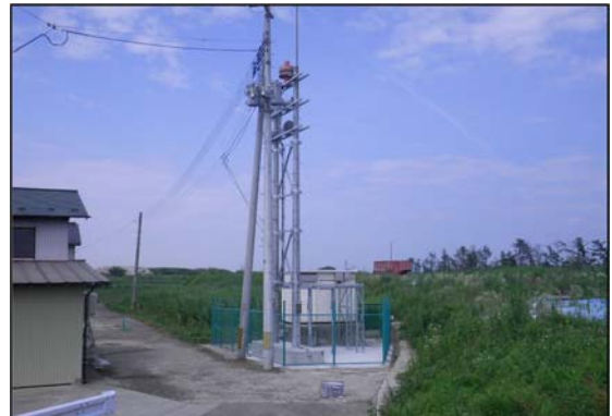
平成24年7月31日 本復旧完了
