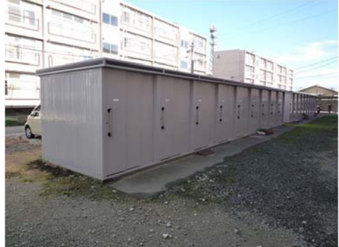
▲平成 24 年 11 月 30 日 本復旧完了
