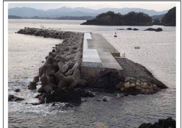
平成24年9月27日 本復旧完了
