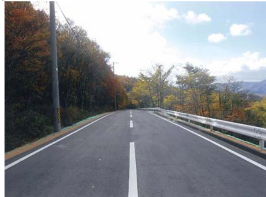
▲平成24年11月2日 本復旧完了
