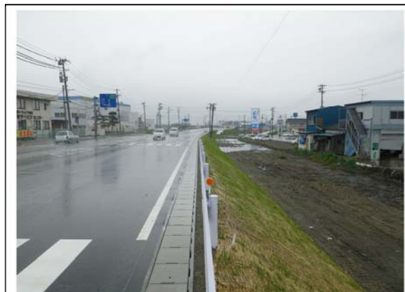
平成24年5月18日 本復旧完了
