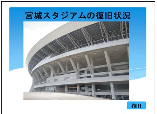
平成 24 年 7 月 13 日 復旧工事完了
