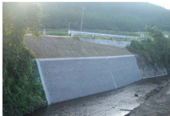
平成24年11月21日 本復旧完了
