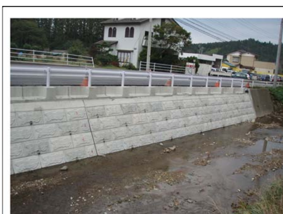
▲平成24年11月13日 本復旧完了
