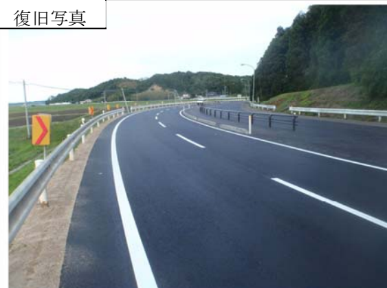
▲平成24年6月21日 本復旧完了
