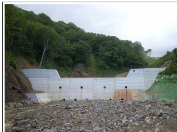
▲平成24年9月18日 耕英東1号砂防えん堤完成
