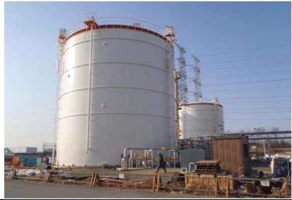
平成25年3月復旧完了
