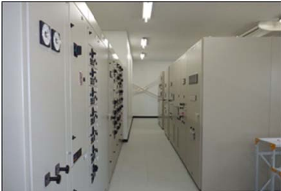
平成24年9月28日 本復旧完了 電気室を脱水機棟2階へ新設（津波対策）
