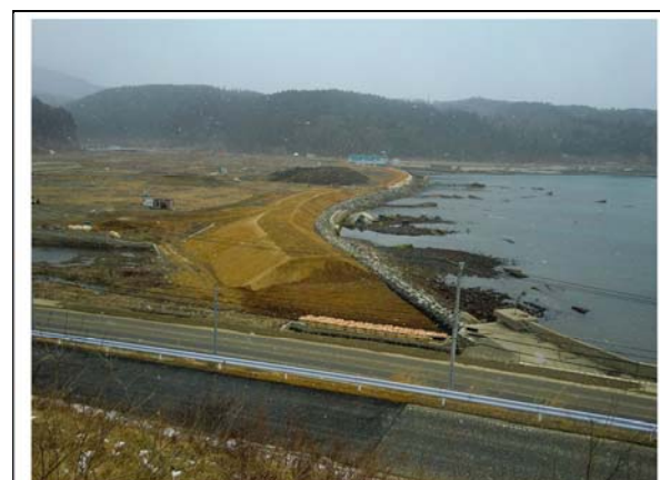
平成25年1月31日 暫定復旧完了
