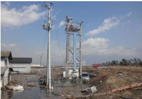
名取川水系増田川 樽水ダム寺野警報所 被災状況
