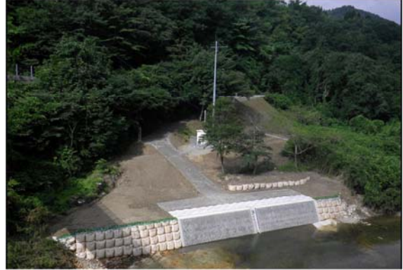
平成24年7月31日 本復旧完了 施設を上流に設置
