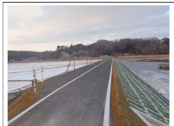
▲平成25年2月12日 本復旧完了
