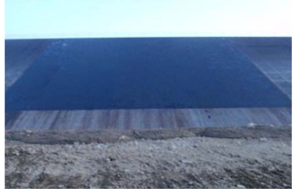
平成25年1月21日 本復旧完了
