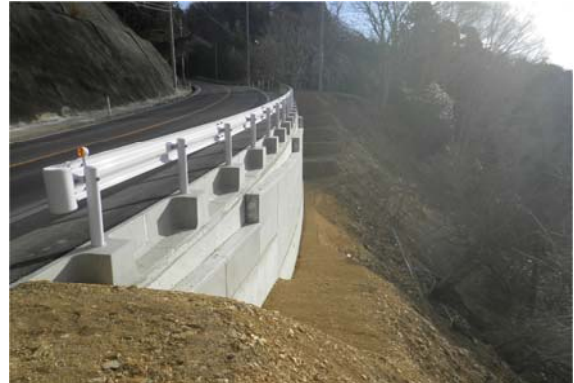
▲平成 25 年 3 月 6 日 本復旧完了
