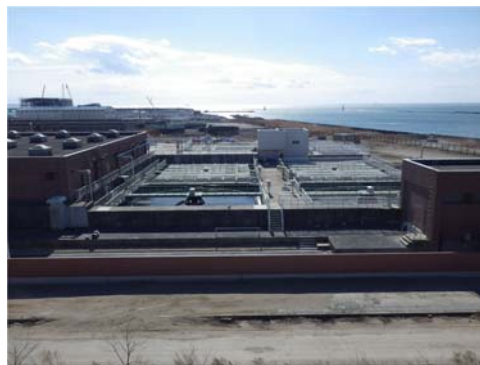
平成24年 9月18日 1系水処理再開・復旧完了 平成24年 12月25日 3系水処理再開・復旧完了
