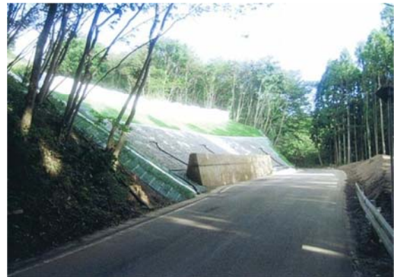
▲平成24年9月25日 本復旧完了
