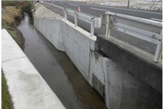
▲平成25年1月15日 本復旧完了
