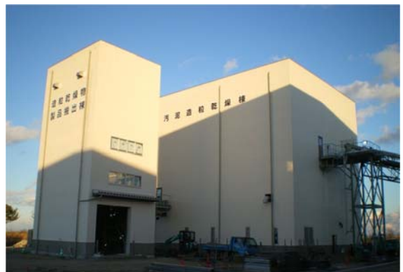
平成25年2月復旧完了
