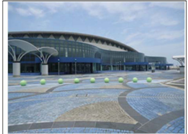
平成 24 年 6 月 29 日 復旧工事完了
