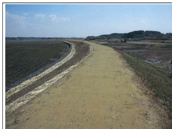
▲平成24年4月13日 本復旧完了
