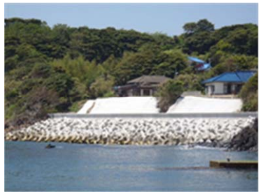
平成24年5月19日 応急復旧完了
