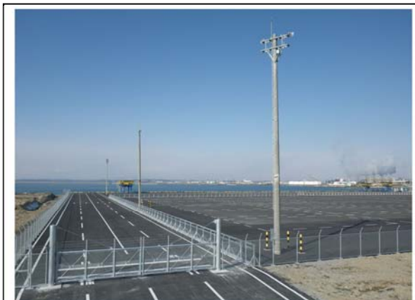
平成25年2月12日 本復旧完了
