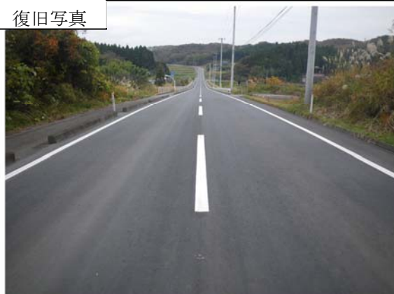
▲平成24年11月26日 本復旧完了
