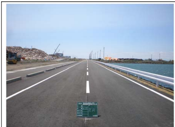
平成24年5月11日 本復旧完了
