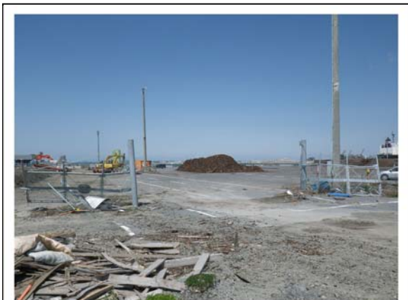
雲雀野中央埠頭荷捌地 損壊状況
