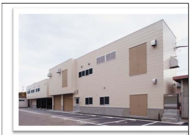
平成 24 年 10 月 31 日 復旧工事完了 新築機械室棟（2階に主要電気設備を設置）
