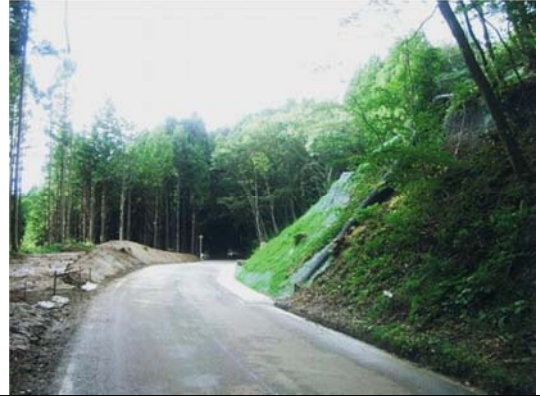
▲平成24年9月25日 本復旧完了
