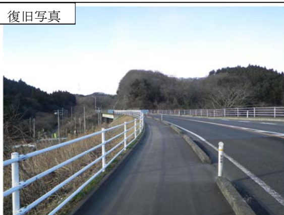
▲平成24年12月10日 本復旧完了
