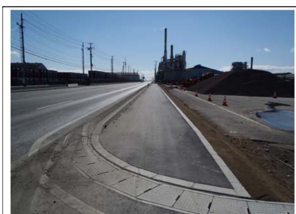
平成25年3月 本復旧完了
