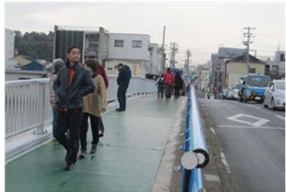
▲石ノ森漫画館の再開にあわせ 平成 24 年 11 月 17 日 歩道復旧完了
