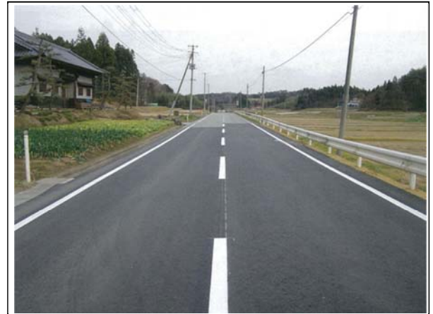
▲平成 24 年 8 月 31 日 本復旧完了
