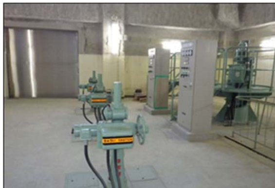
平成24年2月24日 本復旧完了（扉はH25年度） 設備復旧と併せ防水扉を設置（写真奥：津波対策）
