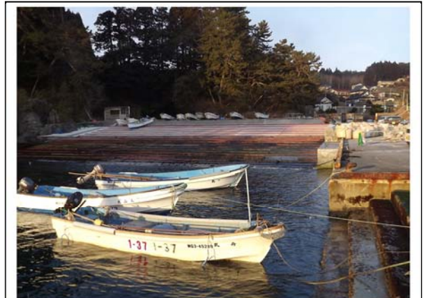
平成25年2月6日 本復旧完了
