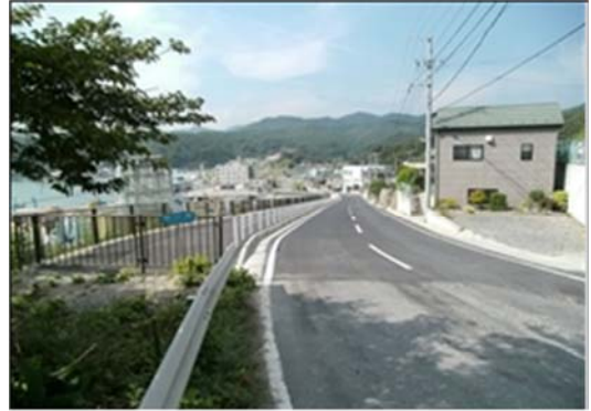
▲平成 24 年 8 月 29 日 本復旧完了
