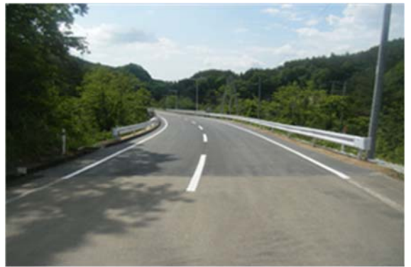
▲平成24年7月25日 本復旧完了
