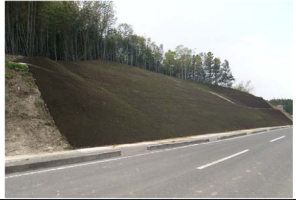
平成24年5月18日 本復旧完了
