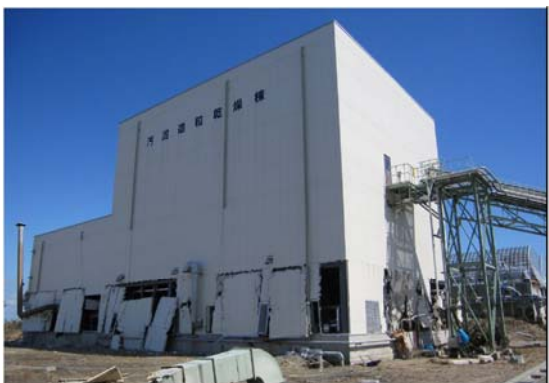
県南浄化センター 汚泥燃料化施設
