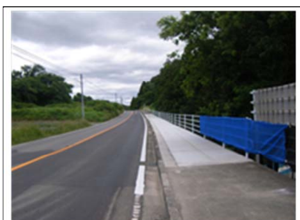
▲平成 24 年 7 月 2 日 本復旧完了
