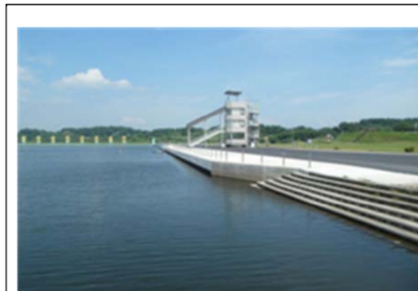
▲平成24年7月20日 本復旧完了
