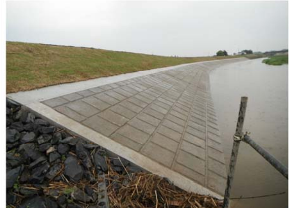
▲平成24年5月18日 本復旧完了
