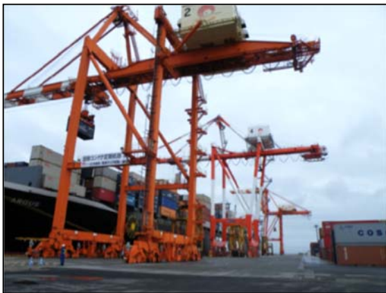
復旧した高砂CYとGC〔仙台塩釜港(仙台港区)〕
