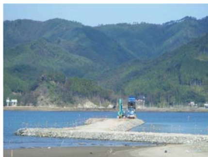
水没している沿岸地域での工事 (横須賀海岸復旧工事)
