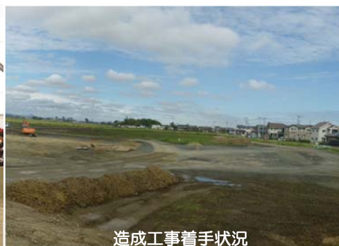
玉浦西工区は 防災集団移転促進事業全国第1号！
