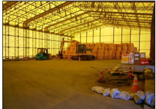
写真7-35 飛灰保管状況
