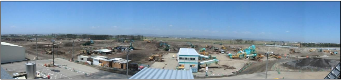
写真7-11 破碎・選別処理施設全景
