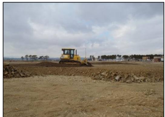
写真7-7 施設造成状況
