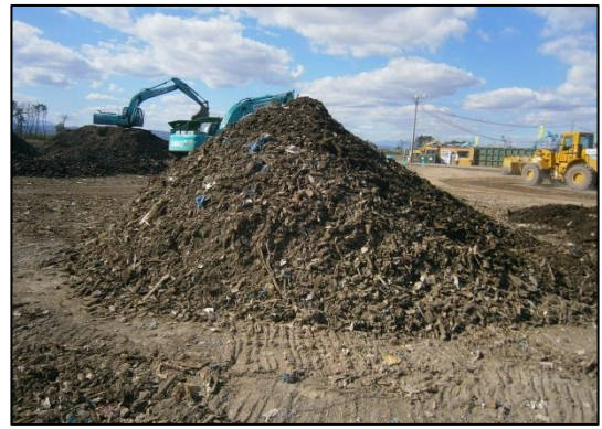
写真7-27 不燃残渣仮置状況
