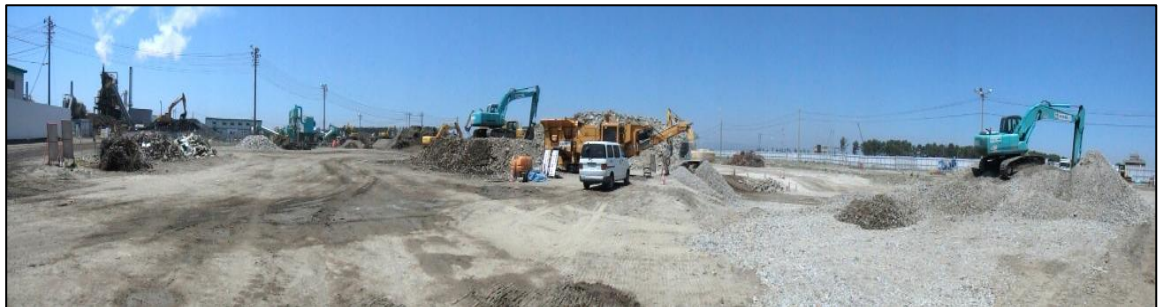
写真7-14 破碎処理全景
