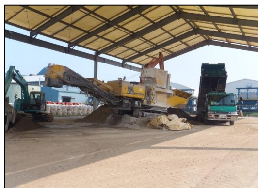
写真5-23 土砂不溶化処理（乾式）
