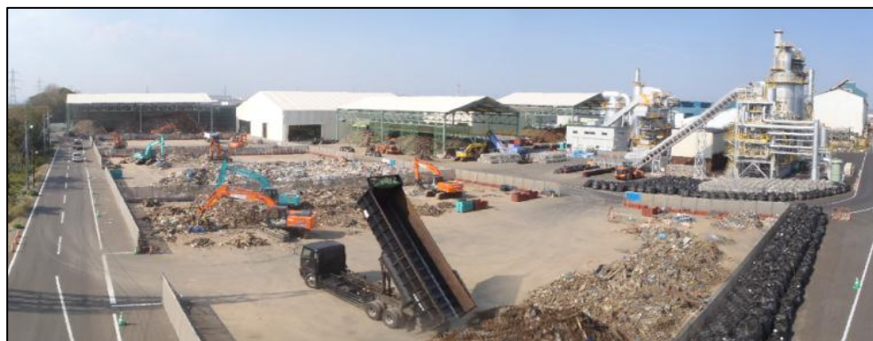
写真5-10 二次仮置き場A完成写真
