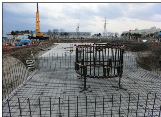
写真5-9 焼却炉基礎施工中の状況
