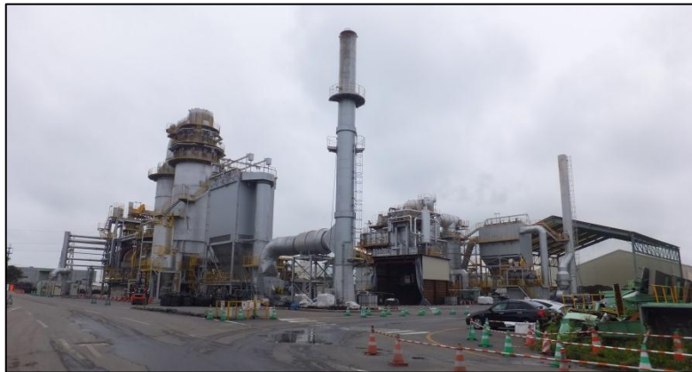
写真5-18 焼却炉全景（左：ロータリーキルン，右：ストーカ炉）
