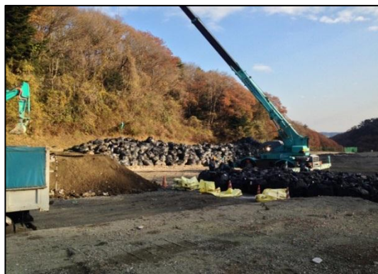
写真5-30 フレコンバッグ詰め肥料の状況
