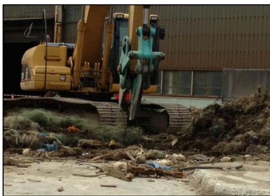
写真5-31 漁網重機選別・裁断の状況
