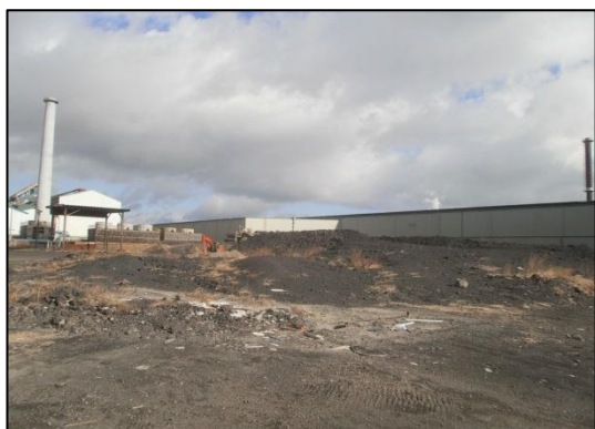
写真5-8 二次仮置き場A着工前
