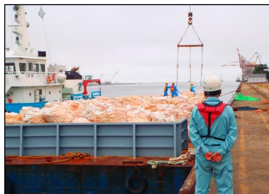
写真5-12 二次仮置き場Aにおける廃棄物荷揚げ
