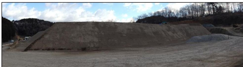
写真5-24 再生土砂(仙台塩釜港仙台港区港湾埋立に利用)
