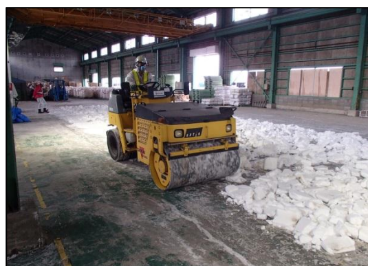
写真5-28 ローラーによる破碎・展開乾燥による塩の再生処理状況
