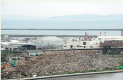
写真：災害廃棄物一次仮置き場(石巻市)
