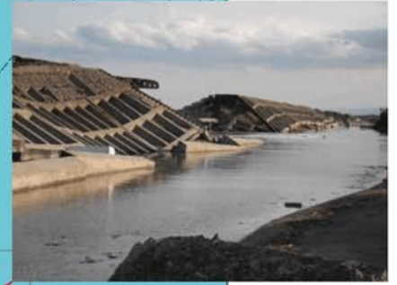
岩沼市二の倉海岸の被害状況
