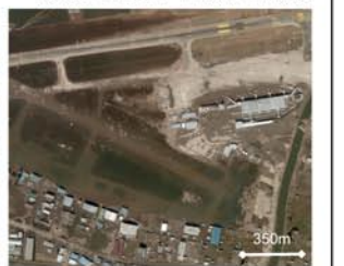
被災後（平成23年3月13日撮影）
