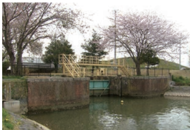
石井閘門(震災前)(平成14年国の重要文化財に指定)
