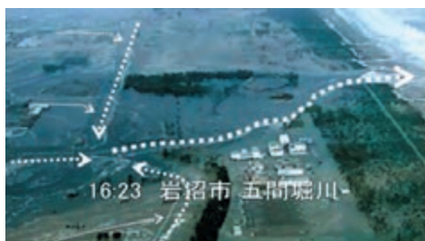
津波の戻り流れの状況 (国土交通省東北地方整備局撮影)
