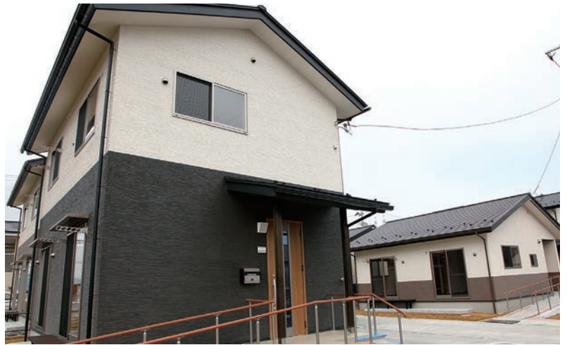
美田園地区に建設中の災害公営住宅（名取市）
