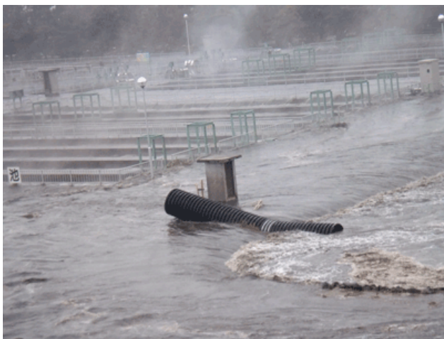
水処理施設大津波浸水状況
