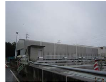
仮設脱水機、稼働中
