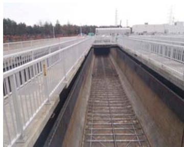
4系、汚泥撤去完了
