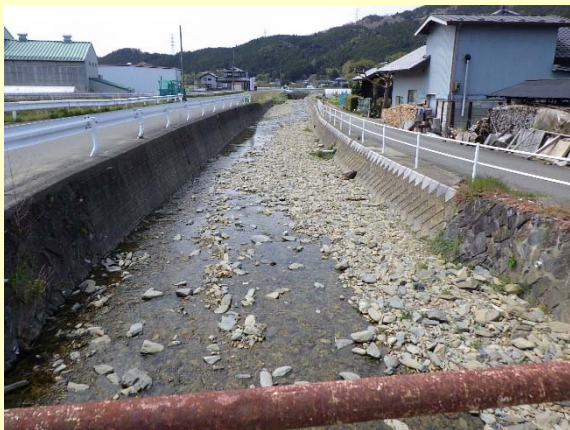
高木川（堆積土砂） 工事着手前
