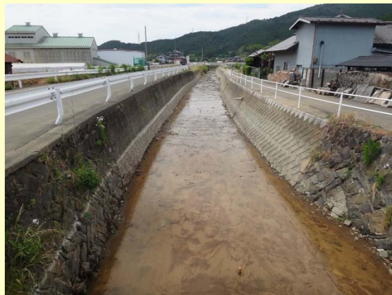
高木川（堆積土砂） 撤去後
