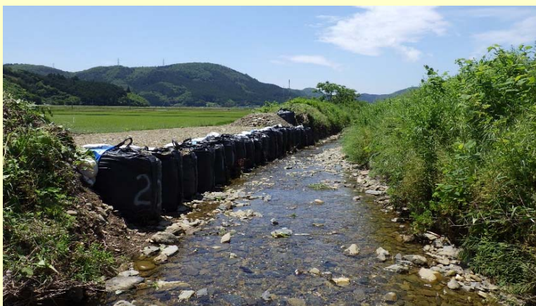
水沼川（破堤箇所） 工事着手前
