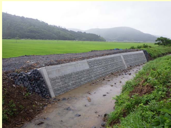
水沼川（破堤箇所） 施工状況
