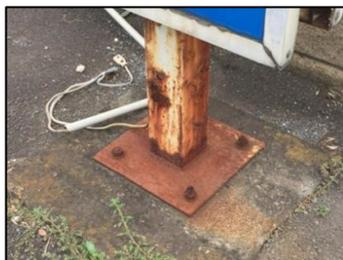
支柱、ベースプレート、アンカー共にさびが顕著な状態
