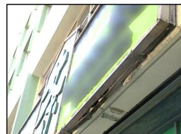
側板底面が破損した状態
