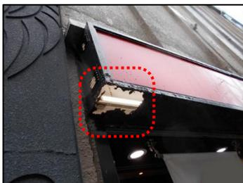
広告板底部の腐食、水抜き穴の詰まり
