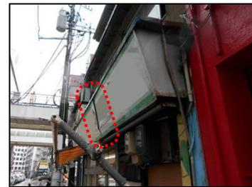
表示面板が外れかかり、継ぎ目に隙間が生じた状態
