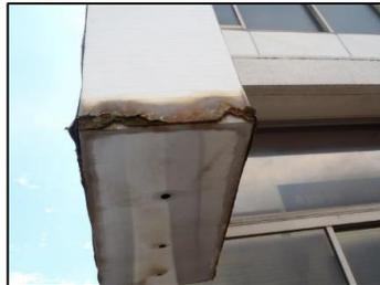
側板の腐食が進行した状態
