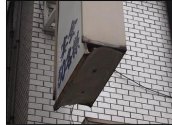
表示面板のひび、破損、変形（たわみ）、外れ、継ぎ目（隙間）
