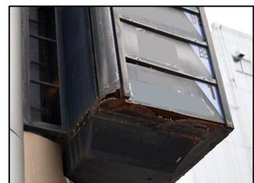
側板底面が腐食、破損した状態
