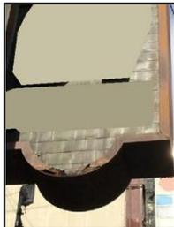
側板底面の腐食が進行した状態
