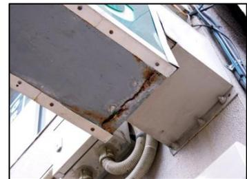
側板底面が破損した状態
