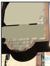
広告板底部の腐食、水抜き穴の詰まり
