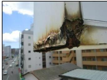
側板の腐食が進行した状態
