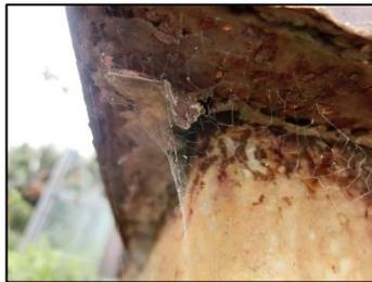
支柱・広告板接合部の腐食が進行した状態
