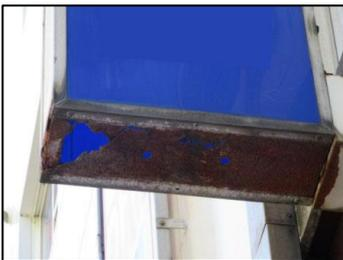
側板底面が腐食、破損した状態
