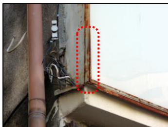
側板・表示面板押さえの変形（ゆがみ、隙間）
