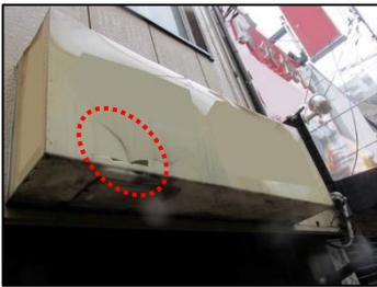
表示面板が破損（ひび割れ）した状態
