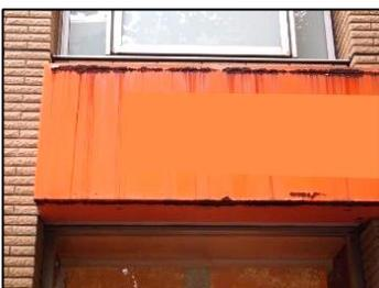
側板の腐食が進行した状態
