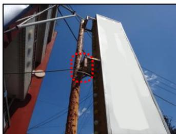
支柱・広告板接合部の腐食・隙間
