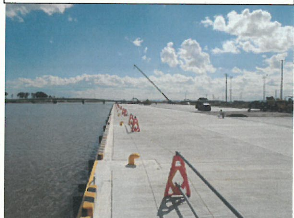
今回利用可能 -3.5m 岸壁 L=200m
