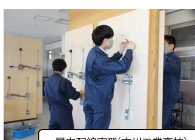
屋内配線実習(古川工業高校)
