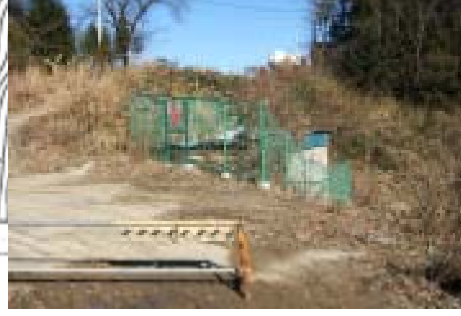
【管理強化対策】立入防止柵設置(元焼却炉脇焼却灰保管庫周辺)
