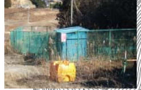
【管理強化対策】立入防止柵設置(元焼却施設通路脇洗浄水槽)
