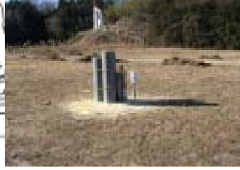
【維持管理】ガス抜き管(H16-11)新設
