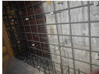
改修工事の状況
