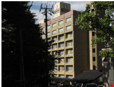
耐震改修完了（鳴子ホテル）
