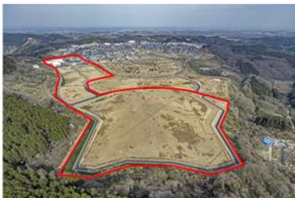
貸付金を活用して造成した工業用地 (愛島西部工業団地)
