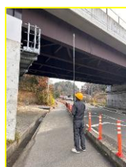
試作した治具を設置し橋梁を撮影
