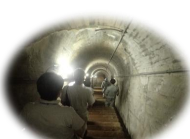
栗駒ダムの監査廊
