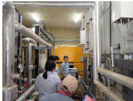
木質バイオマスボイラーの
