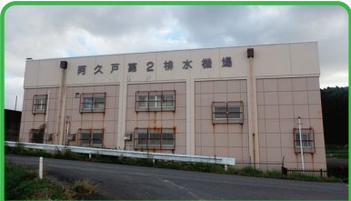
用排水施設等整備事業(湛水防除事業) 阿久戸地区
