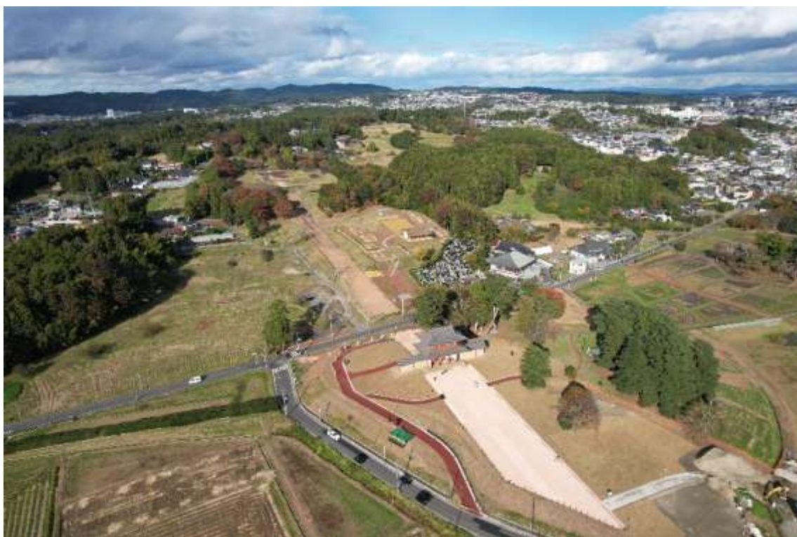
写真7 南門—政庁南面地区整備完成状況
