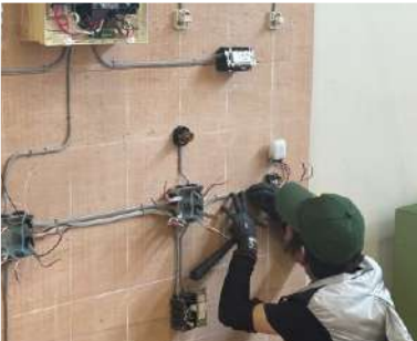
ケーブル工事実習
