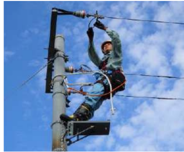
外線工事実習
