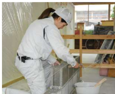
ブロック組積実習
