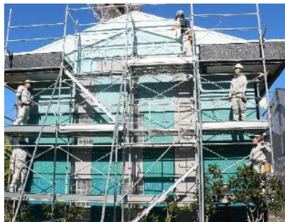
足場実習（足場組立作業）
