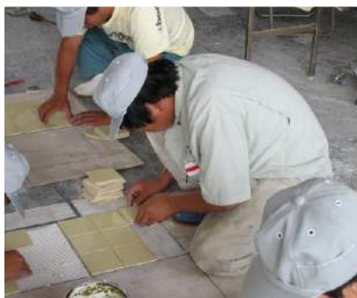
タイル施工実習
