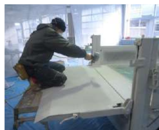
塗装施工訓練
