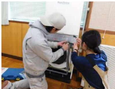
エアコンの取付け実習
