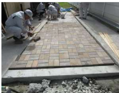
インターロッキング施工実習
