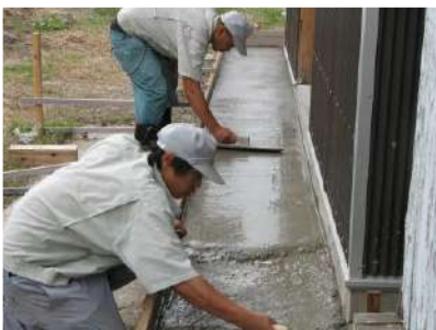
コンクリート施工実習
