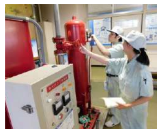
設備工事訓練
