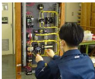
電気工事訓練
