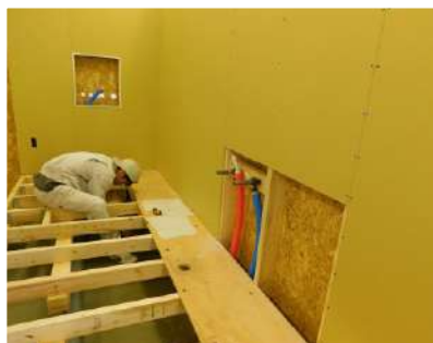
液化石油ガス設備士養成 (模擬家屋作成の様子)
