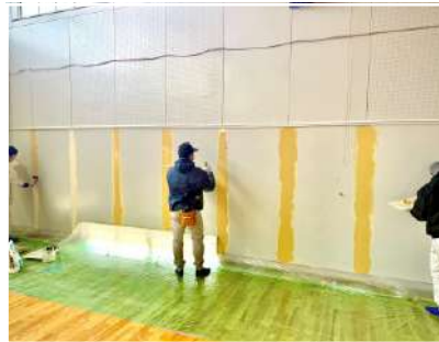
建築物塗装実習（下地処理）
