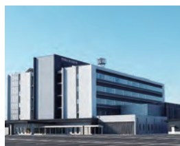
石巻合同庁舎（石巻市）
