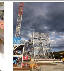
飛散防止用の散水設備設置に支障となる鉄骨撤去
