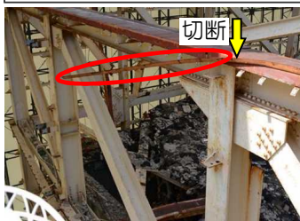
飛散防止用の散水設備設置に支障となる鉄骨撤去
