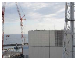
飛散防止用の散水設備設置に支障となる鉄骨撤去
