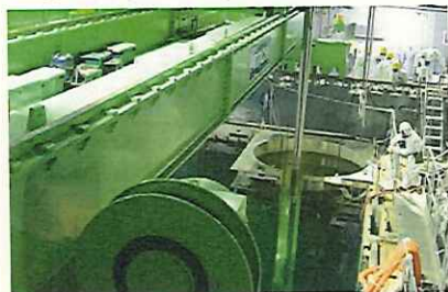
燃料取り出しの様子
