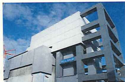
燃料取り出し用カバーの外観
