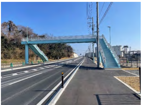
⑥南光町歩道橋
