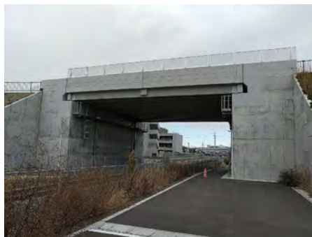
⑤大街道東跨線橋
