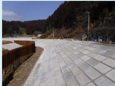
①相川沢川災害復旧工事 ②石巻市北上町十三浜字相川地内 ③法覆護岸工を施工中 ④86%
