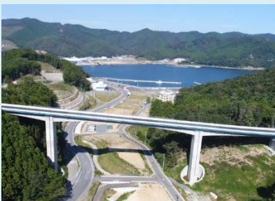
①小乗浜復興道路工事 ②女川町小乗浜地内 ③小乗浜地区で橋梁上部工事を施工中 ④73%
