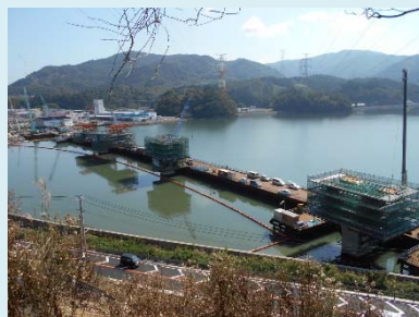
①浦宿道路改良工事 ②女川町浦宿浜地内 ③浦宿地区で橋梁上部工事を施工中 ④55%
