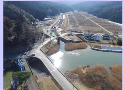
①加茂川河川改修工事 ②石巻市福地地 内 ③橋梁下部工及び樋門を施工中 ④ 28%
