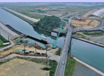
①宮戸道路改良工事 ②東松島市宮戸地内 ③松ヶ島橋の施工中 ④60%
