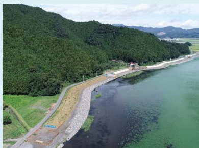
①富士川外1河川災害復旧工事 ②石巻 市針岡地内外 ③地盤改良工事及び樋管 工事を施工中 ④60%
