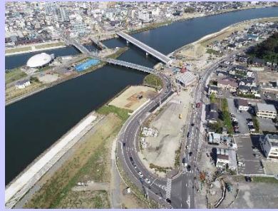
①国道398号内海橋災害復旧工事 ②石巻市中央地内 ③内海橋が完成 取 り付け道路を施工中 ④69%
