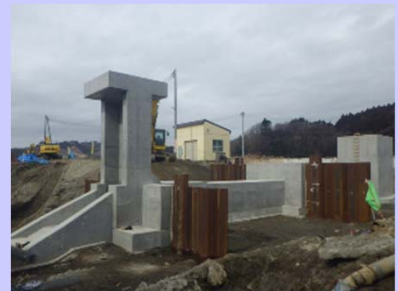
①追波沢川外災害復旧工事 ②石巻市北上町十三浜字江川地内外 ③樋管工事を施工中 ④97%
