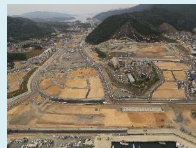
①国道398号女川市街地道路改良工事 ②女川町女川浜地内 ③女川浜地区で舗装工事を施工中 ④96%
