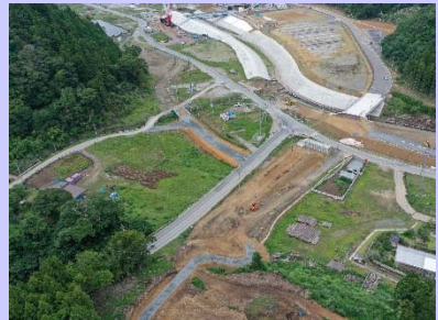
①国道398号雄勝復興道路工事 ②石巻市水浜～味噌作地内 ③味噌作地区で道路改良工事を施工中 ④24%
