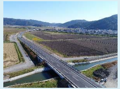
①国道398号石巻バイパスⅡ期工事 ②石巻市大瓜地内 ③全線供中 側道部 施工中 ④97%
