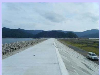
①横須賀地区海岸災害復旧工事 ②石巻 市長面地内 ③天端工事を施工中 ④97%
