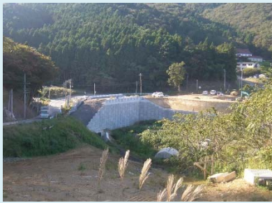
①高白復興道路工事 ②女川町高白浜地 内 ③補強土壁工事を施工中 ④45%
