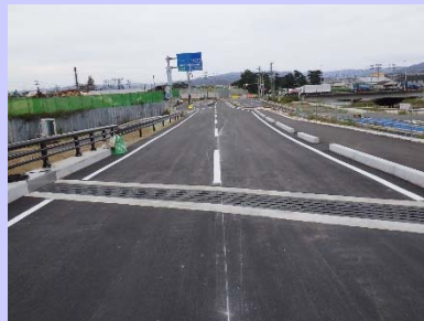
①大曲道路災害復旧工事 ②東松島市大曲地内 ③大曲地区で舗装工を施工中 ④65%
