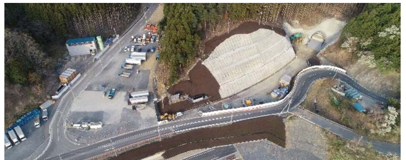
国道398号 女川崎山地内 改良延長L=994m(うちトンネル延長700m)
