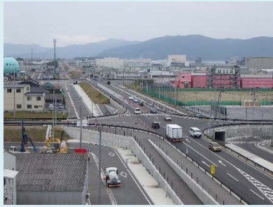
①門脇流留線道路改築工事 ②石巻市門脇～魚町地内 ③高盛土道路及び側道部 施工中 ④58%
