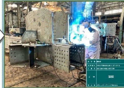
④ 組立・溶接
