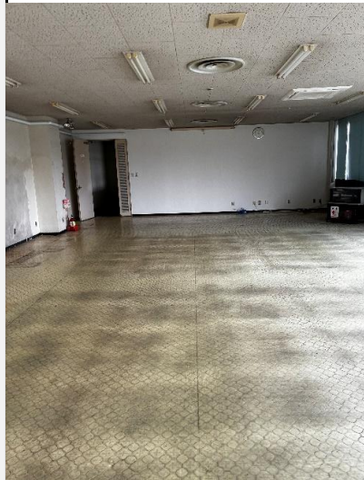
建物内部写真
