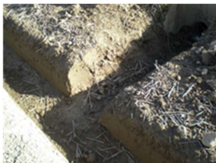
写真1 明きよと排水溝をつなぐ
