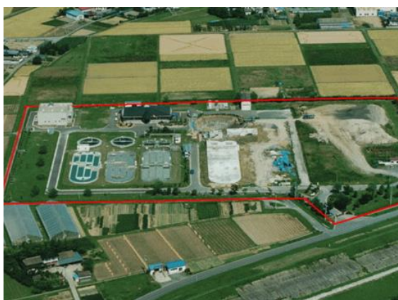
鹿島台浄化センター（鳴瀬川流域）
