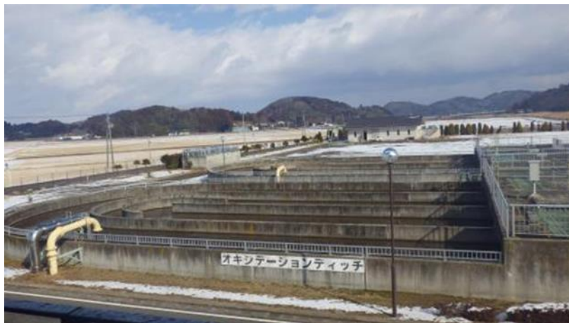
石越浄化センター（迫川流域）
