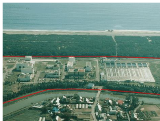
県南浄化センター（阿武隈川下流流域）
