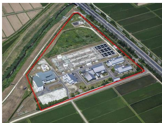
大和浄化センター（吉田川流域）
