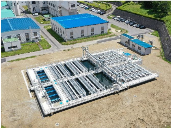
濁度低減処理施設の運用 (仙台北部工水)
