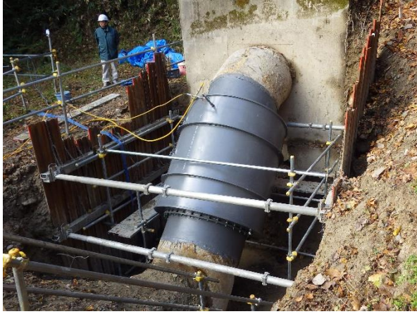
伸縮可とう管の補強 (大崎広水)
