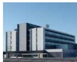
石巻合同庁舎(石巻市)
