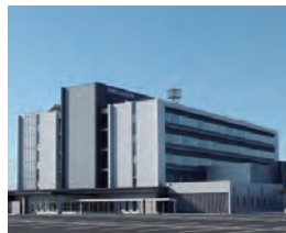
石巻合同庁舎(石巻市)
