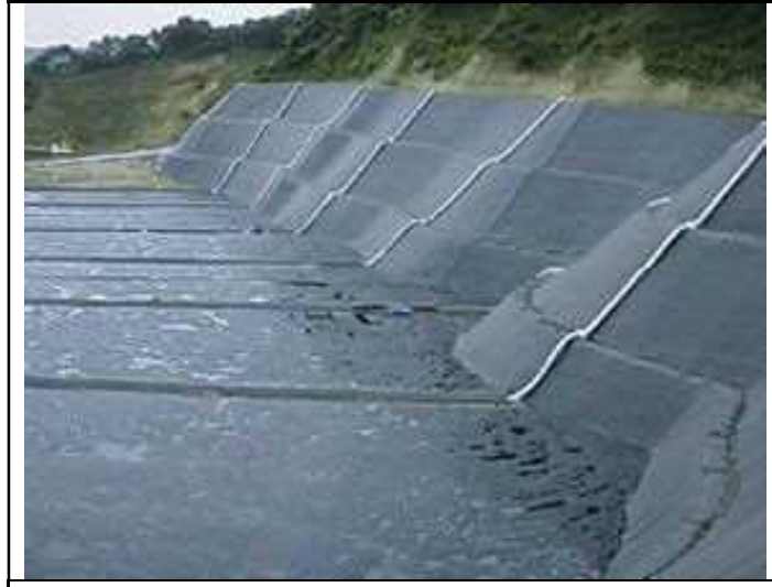
遮水シート施工後の状況
