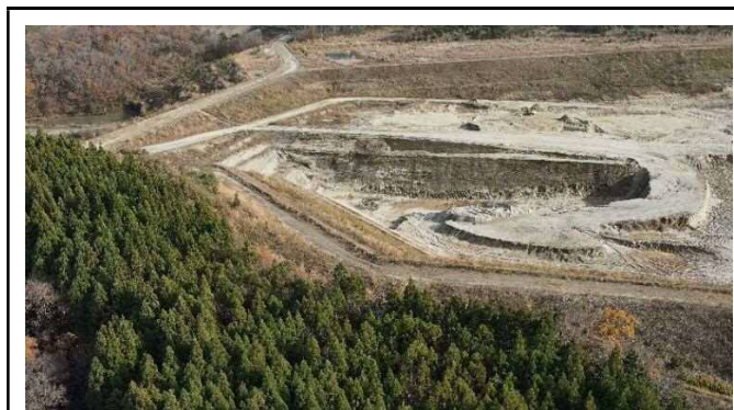
造成工事箇所
