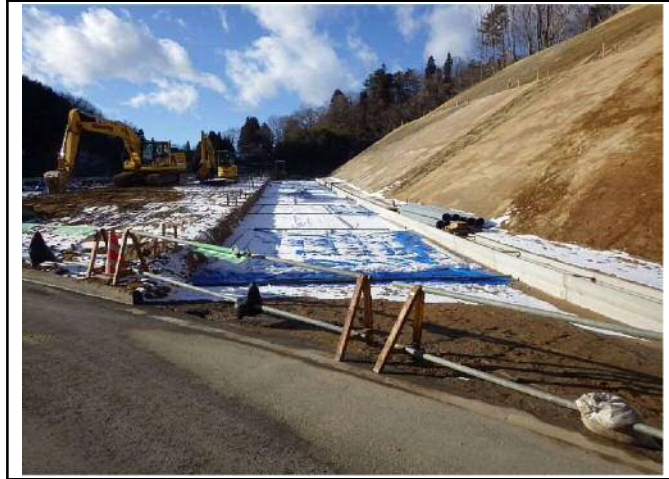
基礎地盤掘削作業の状況
