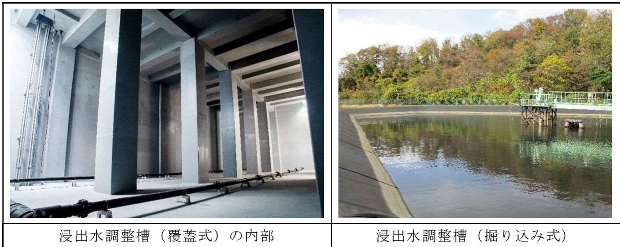
図 2.6.1-5 浸出水処理施設工事イメージ
