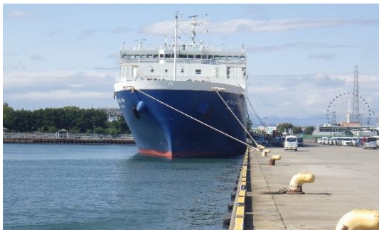
耐震強化岸壁 〔仙台塩釜港（仙台港区）〕
