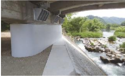
橋梁耐震化（橋脚巻立て）
