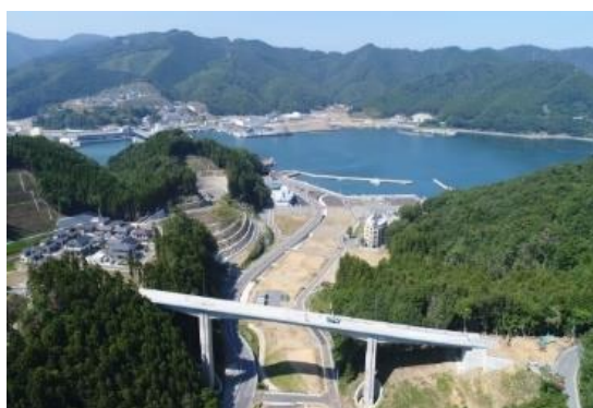
離島及び半島道路整備 〔(主) 女川牡鹿線 小乗浜〕
