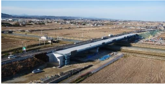
高規格幹線道路整備（4車線化）
