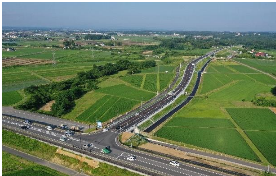
みやぎ県北高速幹線道路
