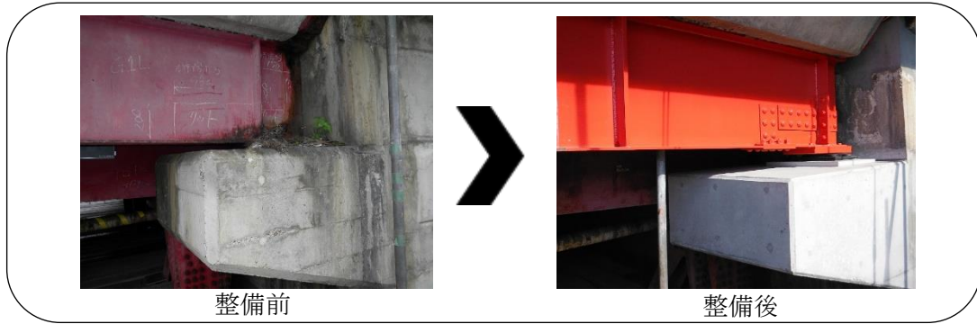
橋梁の予防保全型管理（支承部分）
