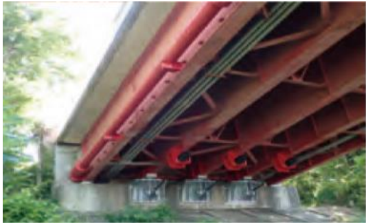
橋梁耐震化（落橋防止）
