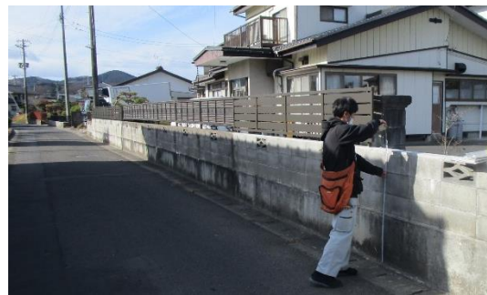
通学路沿いのブロック塀 （点検状況）
