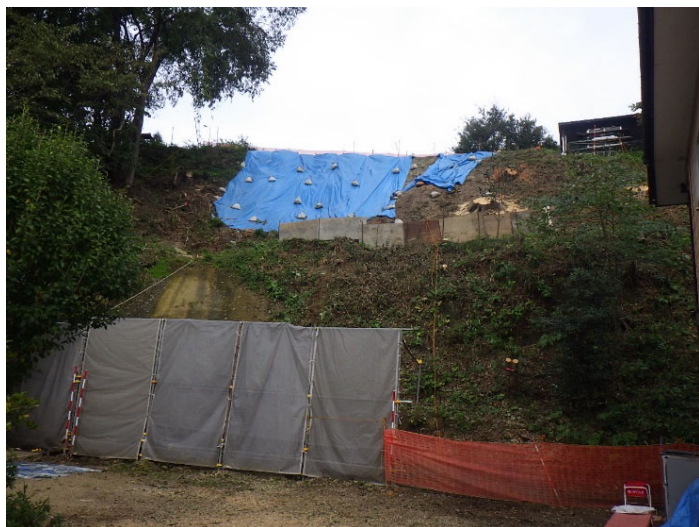
○仮設防護柵設置
