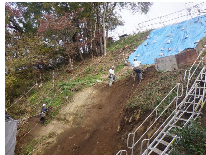
→ ○ロープ足場設置
