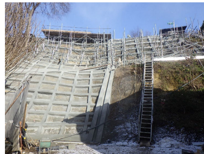
→ ○吹付法枠完成
