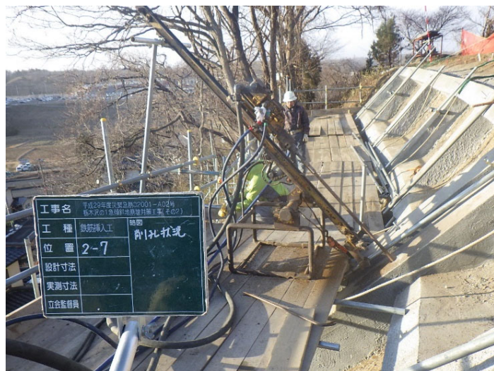
○鉄筋挿入工
