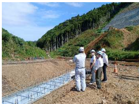
「川内沢ダム建設現場」
