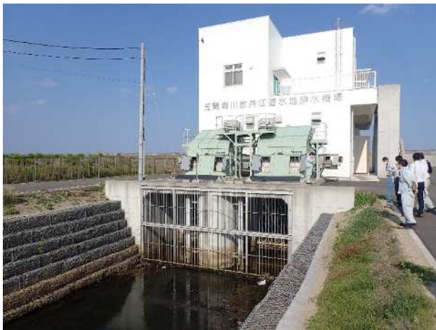
②赤井江遊水地排水機場の外観確認
