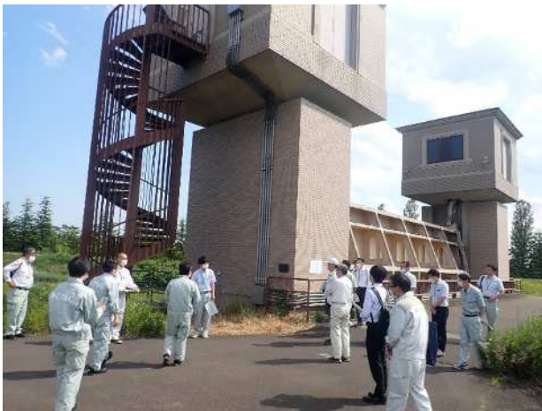
①仙石水門の外観確認
