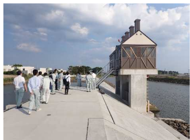
②赤井江水門の外観確認
