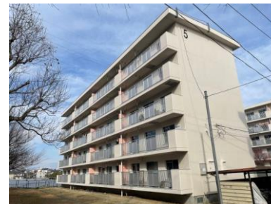
県営住宅外壁改修工事
