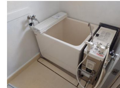
県営住宅浴槽・風呂釜設置工事
