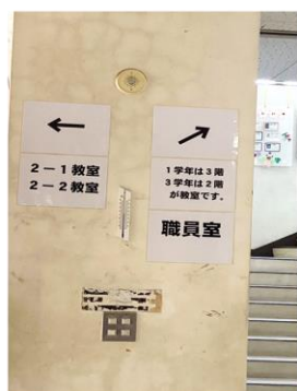
校舎全体を見る配置図がなく、教室案内表示の書体や掲示場所がバラバラだった。
