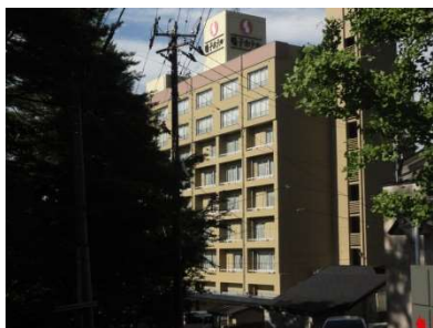
耐震改修完了(鳴子ホテル)
