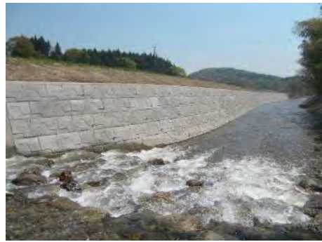
平成 27 年災 烏川河川災害復旧事業
