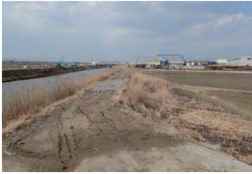
⑮一級河川阿武隈川水系五間堀川 岩沼市早股地内 河川災害復旧事業
