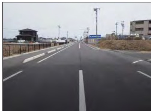
(都)山下駅前線山寺工区(施工中)
