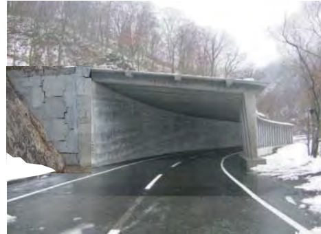
④ 平成30年11月 完 成
