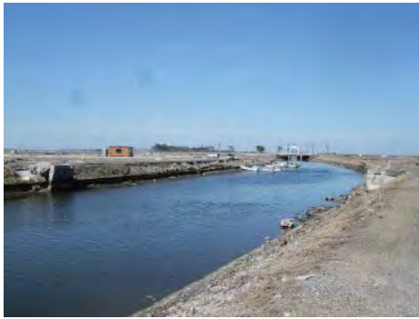
⑥一級河川名取川水系中貞山運河 名取市閑上地内 河川災害復旧事業
