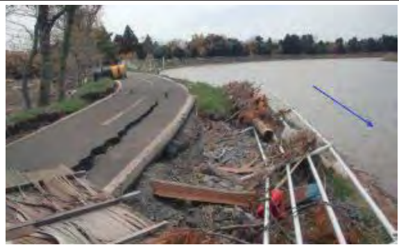
⑩ 定川 東松島市大曲字川前地内 着工前
