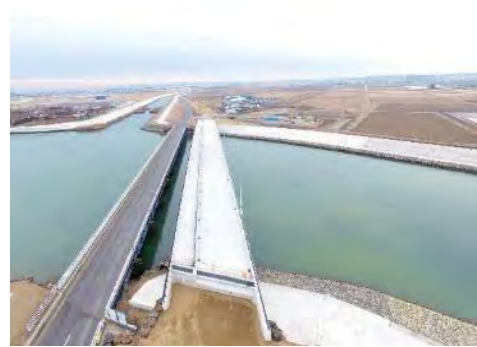
⑦ 平成31年3月 現在 上部工 施工中
