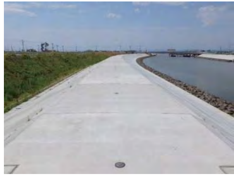
③ 平成30年10月 一部完成
