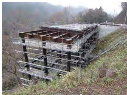
④ 平成31年3月 現在 施工中
