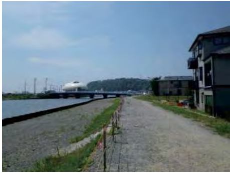
③ 内海橋 石巻市中央地内 着工前
