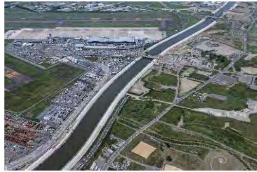
① 平成30年9月 一部完成
