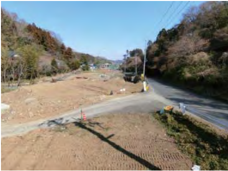
③ (一)利府中インター線 塩竈市庚塚地内 社会資本整備総合交付金(復興枠)避難路整備
