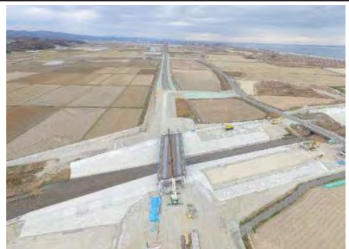
⑤ 平成30年12月 施工中
