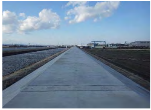
⑮ 平成31年3月 完成
