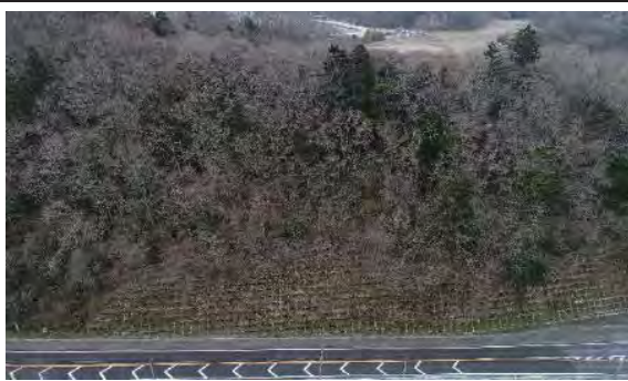
⑧ (主) 奥松島松島公園線 松島町手樽地内 社会資本整備総合交付金 (復興枠) 法面補修
