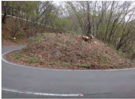
⑨ 国道398号 栗原市花山温湯地内 温湯道路改良
