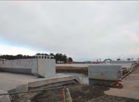
⑭ 一級河川阿武隈川水系五間堀川 岩沼市下野郷地内 河川災害復旧事業
