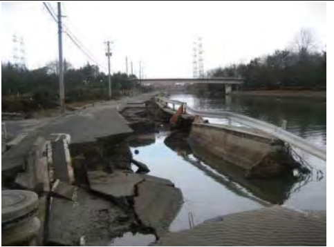
⑪二級河川砂押川水系砂押川 多賀城市大代地内 河川災害復旧事業
