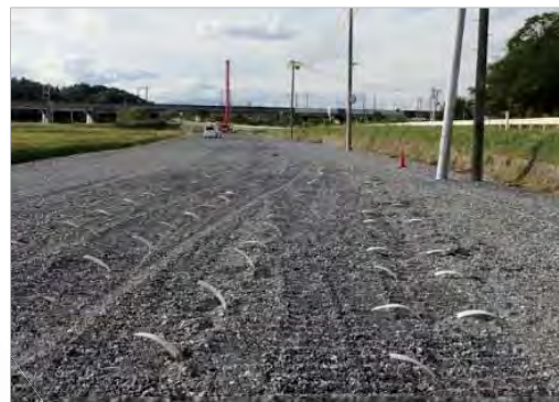
築堤工(地盤改良)の施工状況
