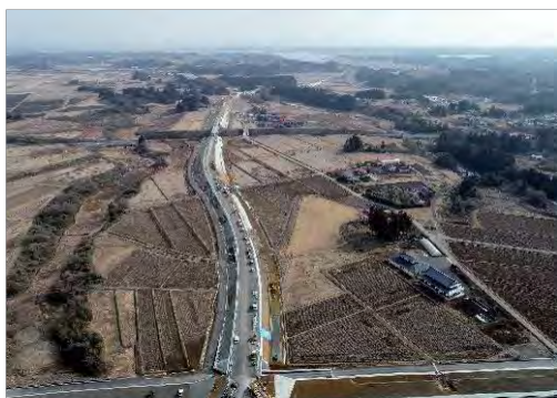
国道 4 号築館バイパスへの接続工事状況
