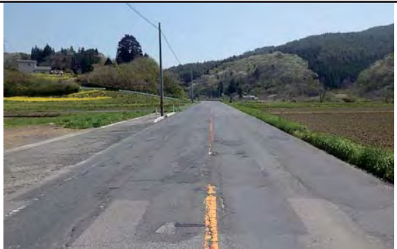
⑩ 登米市東和町米川字東上沢地内 米谷外舗装補修工事 (国346号 東上沢工区)
