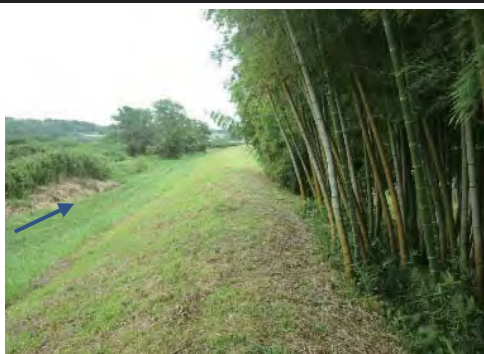
⑤ 小山田川 栗原市瀬峰西原前地内 小山田川河川改修
