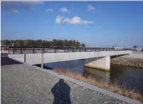
⑭ 平成31年3月 完成
