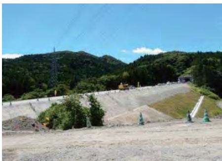
① (主) 岩沼蔵王線 岩沼市志賀地内 道路改良事業
