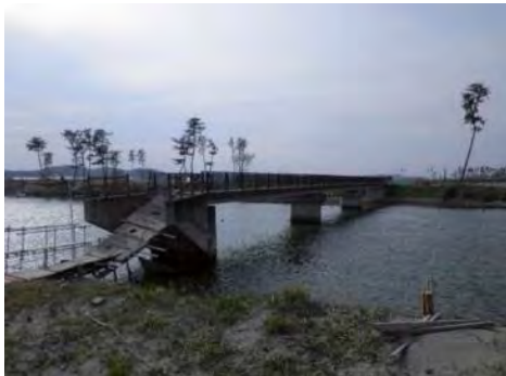
⑧ (一) 石巻松島自転車道線 東松島市浜市地内 浜市橋橋梁災害復旧工事
