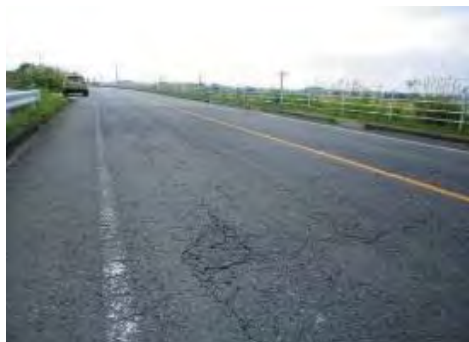
⑫ 国道398号 栗原市若柳川南地内 川南舗装補修
