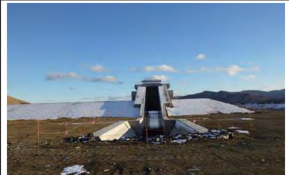
⑤ 平成31年2月 現在 施工中
