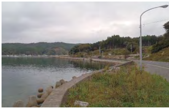
⑦ 清水田地区海岸外 石巻市清水田浜地先外 海岸堤防復旧工事
