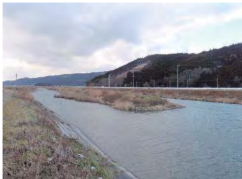
⑯ 311地震災第5020号 石巻市大網 地内 中島川 河川堤防沈下
