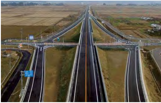
みやぎ県北高速幹線道路Ⅱ期中田工区 完成
