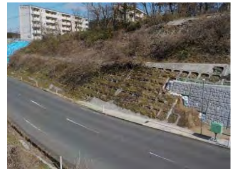
⑪ (主) 河南築館線 栗原市築館萩沢土橋地内 萩沢土橋交通安全施設整備
