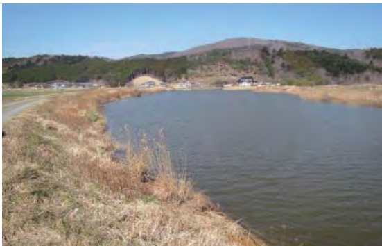
④ 真野川 石巻市大瓜地内 河川堤防復旧工事
