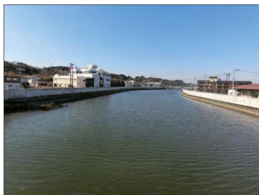
高城川災害復旧(完成)
