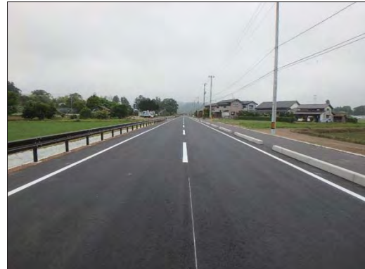
(主)岩沼蔵王線小山自歩道整備(完成)
