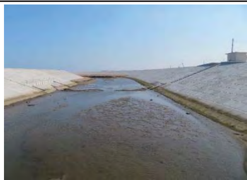
⑰ 平成31年2月 完成
