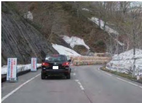
④ 国道398号 栗原市花山湯浜地内 湯浜「なだれ沢」スノーシェッド
