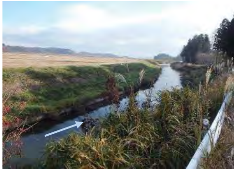
③ 荒川 栗原市築館萩沢地内 荒川河川改修
