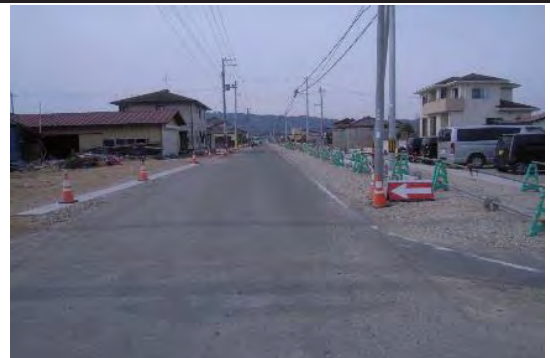
④ 平成31年3月 施工中
