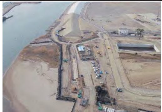
⑧ 平成31年2月 施工中
