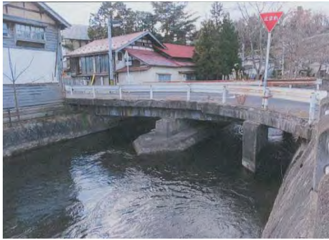
③ (一) 岩出山宮崎線 大崎市岩出山字二ノ構地内外 内川橋外橋梁補修工事
