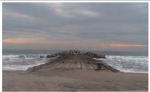
⑨ 浜市地区海岸 東松島市浜市牛網海辺地内 着工前
