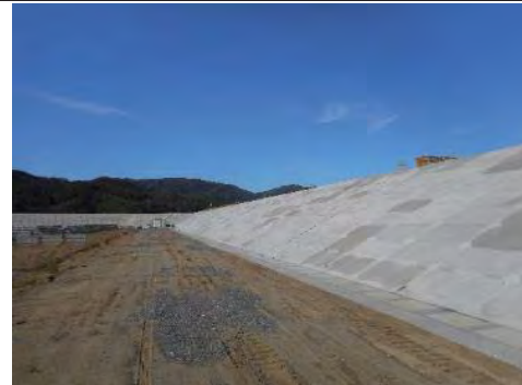
⑬ 平成31年2月 現在 施工中
