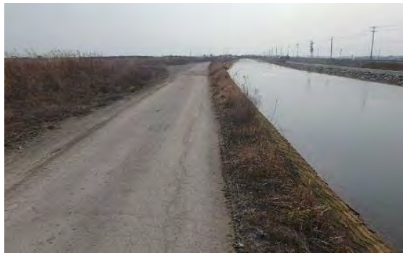
⑪ 南北上運河 東松島市大曲地内 着工前
