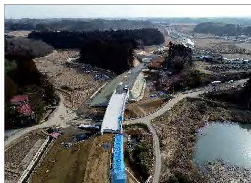
菟沢忽滑沢(ぬかりさわ)本線橋の桁架設完了状況
