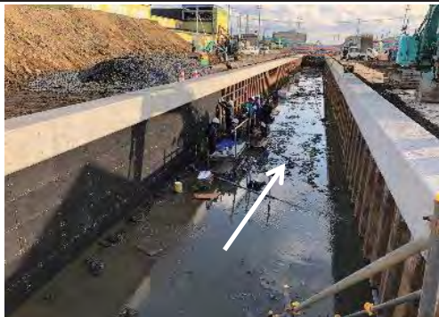
⑤ 平成31年3月 捷水路施工中
