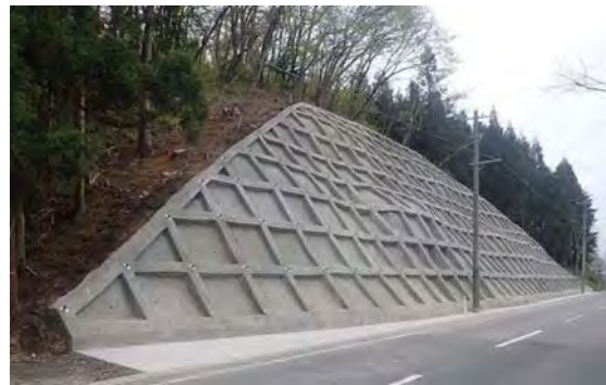
(一) 東和登米線六反災害防除工事 完成
