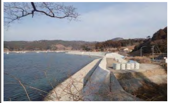
⑦ 平成31年2月末 現在 施工中
