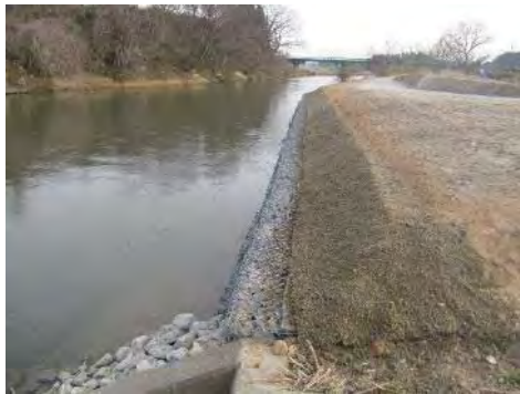
平成 27 年災 田川河川災害復旧事業
