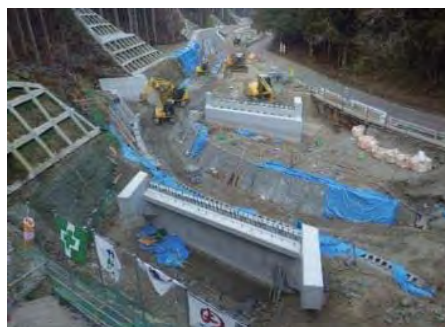
① 平成31年3月 現在 姥ヶ森山橋(下部工) 施工中
