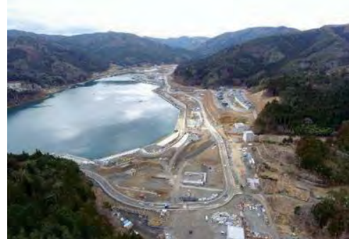
⑪ 平成31年2月 現在 本工事施工中
