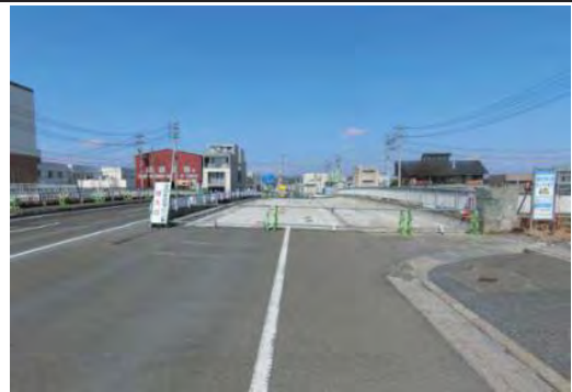
② 平成31年3月 施工中
