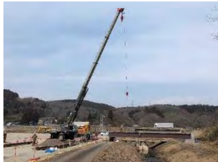
② 平成31年3月 現在 施工中
