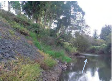
⑦ 三迫川 栗原市金成大原木地内 平成27年 河川災害復旧工事
