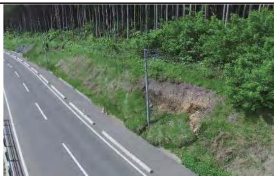
① (主) 河南築館線 遠田郡涌谷町小里字柳沢地内 松崎道路災害復旧工事
