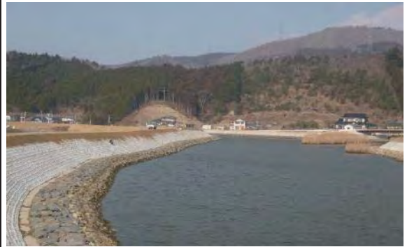
④ 平成31年2月 現在 施工中
