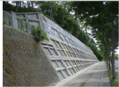
① 平成30年6月 完成
