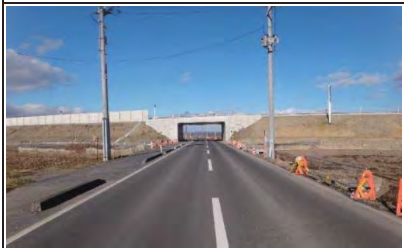
④ 平成30年12月 現在 完成
