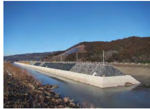
⑯ 平成31年2月 現在 本復旧 施工中
