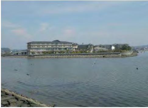
⑫ 二級河川高城川水系高城川 松島町高城地内 河川災害復旧事業
