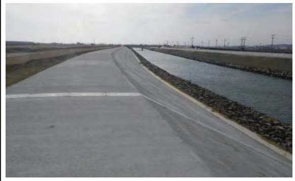
⑪ 平成31年2月現在 法覆護岸工 施工中
