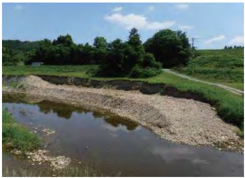
④ 二級河川高城川水系新堀川 大崎市鹿島台 地内 新堀川河川災害復旧工事 (H29災)
