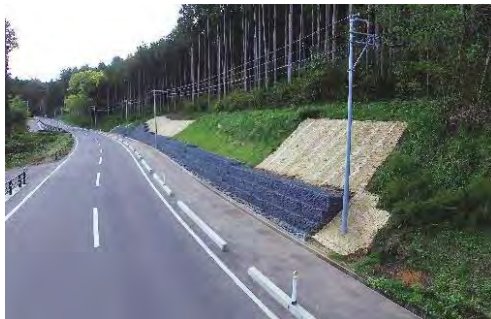
平成 29 年災 松崎道路災害復旧事業
