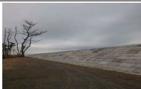
① 平成31年2月 現在 本復旧 施工中
