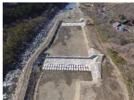
② 平成31年3月 現在 施工中
