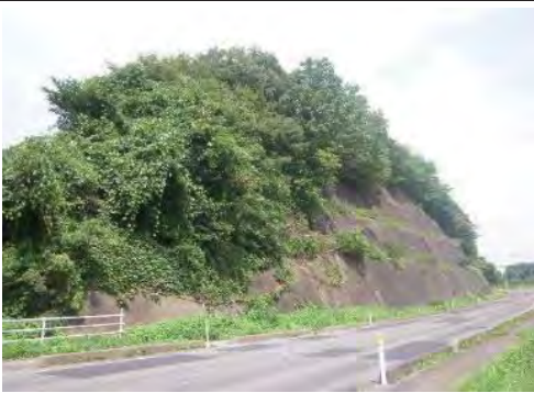
⑦ (国) 346号 松島町根廻地内 社会資本整備総合交付金 (復興枠) 法面補修
