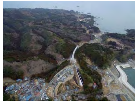
⑩ 平成31年2月 現在 本工事施工中（相川3号橋周辺）
