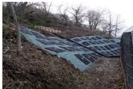
② 平成31年2月 施工中（法面对策施工中）
