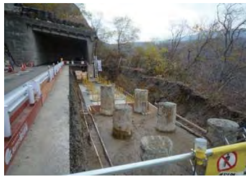
⑤ 平成30年11月 施工中 (下部工施工中)
