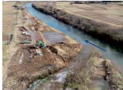
① 平成31年2月 施工中（河道掘削施工中）
