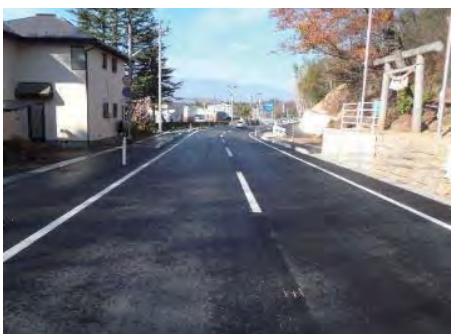
⑤ (主) 白石丸森線 白石市大鷹沢大町地内 道路改良事業
