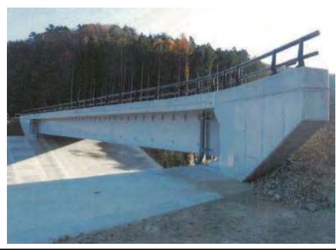
⑫ 平成31年2月 本工事施工中（雄勝3号橋上部工完成）
