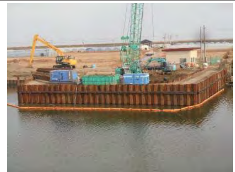
⑤ 平成31年3月 施工中
