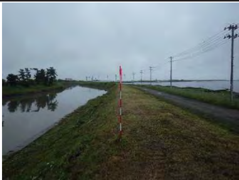
⑦一級河川名取川水系川内沢川 名取市下増田地内 社会資本整備総合交付金事業（復興枠）
