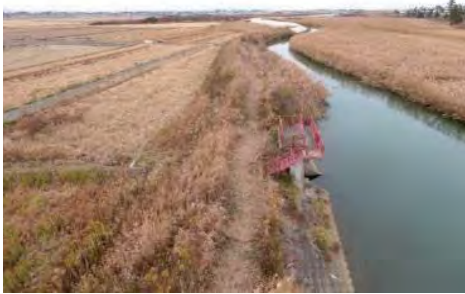
②一級河川名取川水系増田川 名取市杉ヶ袋地内 河川災害復旧事業
