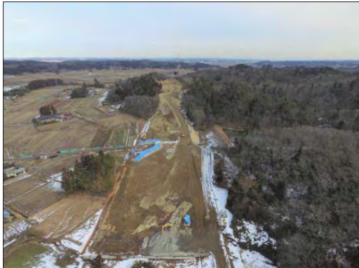
(一)大衡仙台線宮床工区(施工中)
