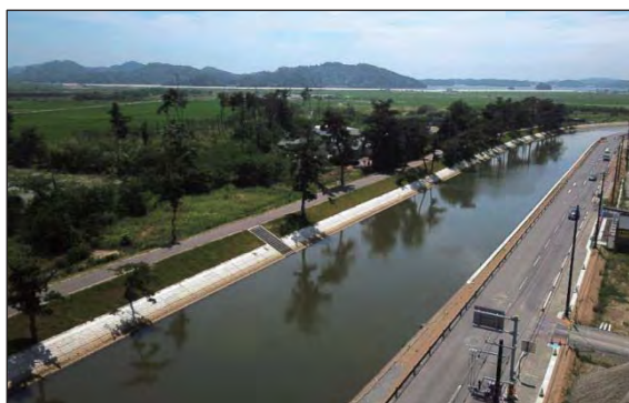
(主)奥松島松島公園線・東名運河災害復旧(完成)
