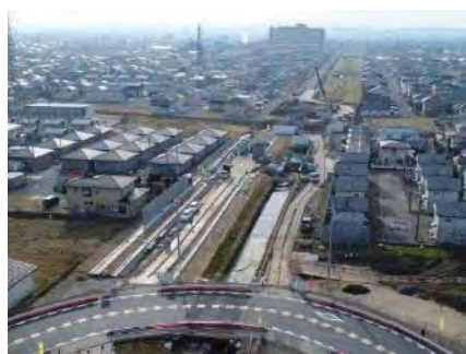
現在施工中の JR 陸羽東線上流部
