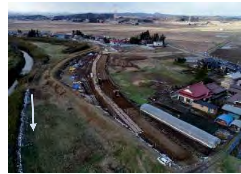
② 平成31年2月 施工中（築堤施工中）
