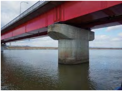
⑥ (主) 塩釜亙理線 岩沼市寺島地内外 社会資本整備総合交付金 (復興枠) 耐震補強
