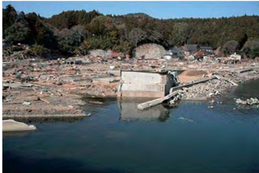
⑩ 相川復興道路 石巻市北上町十三浜字相川地内 橋梁上部工・取付道路流出状況
