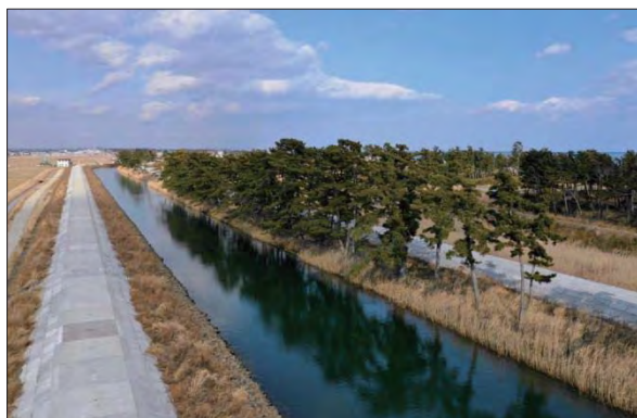
五間堀川(1)災害復旧(完成)
