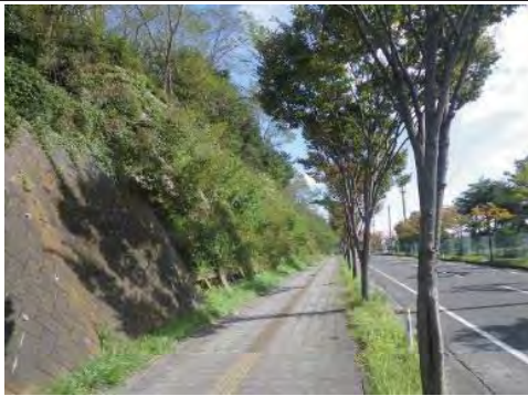
① (主) 塩釜七ヶ浜多賀城線 多賀城市笠神地内 社会資本整備総合交付金 (復興枠) 法面補修
