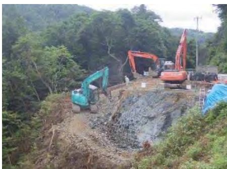
④ (国) 113号 白石市福岡蔵本地内 道路改良事業
