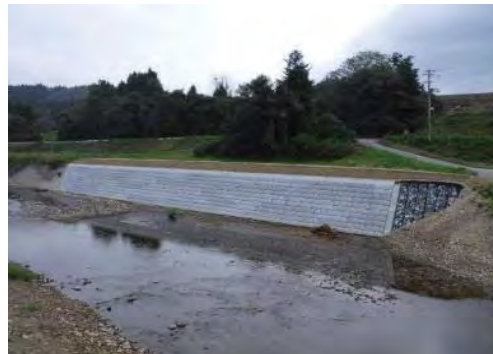
④ 平成30年11月27日 完成
