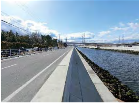
⑪ 平成30年8月 完成
