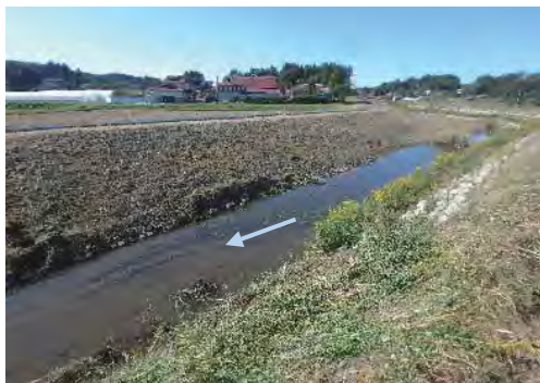
④ 照越川 栗原市築館照越地内 照越川河川改修
