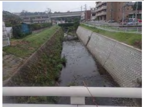
⑩二級河川七北田川水系仙台川 仙台市泉区 八乙女地内 河川災害復旧事業
