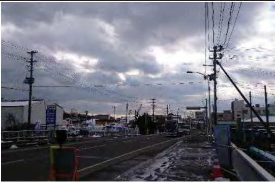
② (都) 八幡築港線 塩竈市中の島地内 復興交付金 避難道路整備
