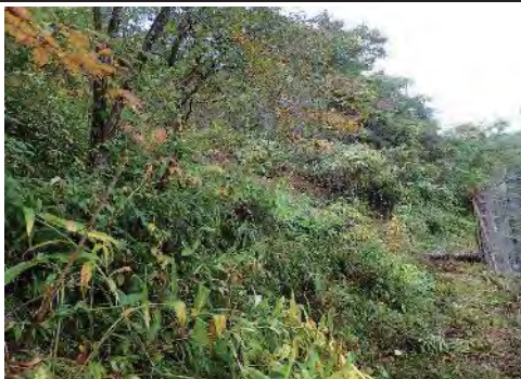
② 北沢向 栗原市鶯沢北沢向地内 北沢向急傾斜地崩壊対策
