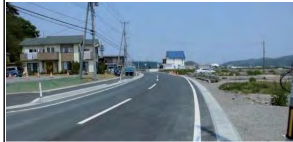
④ 平成28年6月 完成
