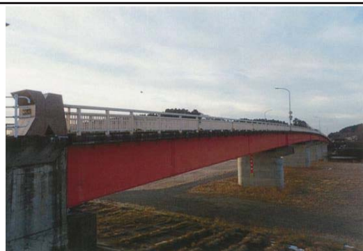
② 国道346号 大崎市鹿島台木間塚柿ノ木平地内 感恩橋橋梁耐震補強工事
