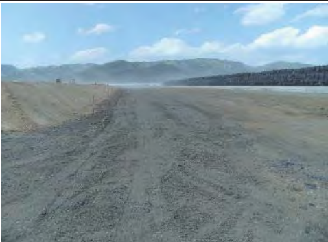
⑬ 横須賀地区海岸 石巻市長面地内 防潮堤 整備
