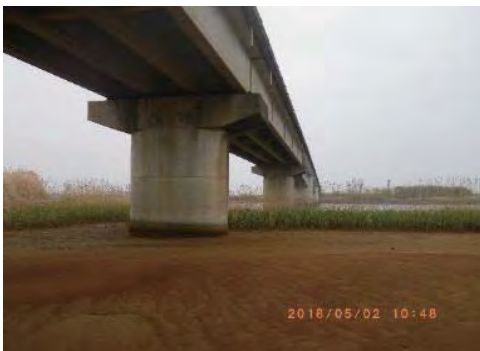
⑪ (主) 塩釜亙理線 名取市閑上地内 社会資本整備総合交付金(復興枠) 閑上大橋耐震補強
