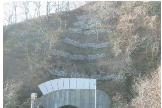
④ 平成30年12月7日 完成
