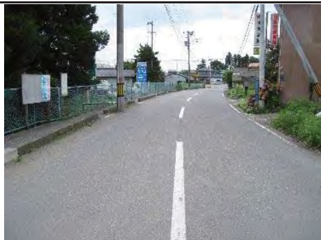
⑬ (主) 河南築館線 栗原市築館内沢地内 (都) 源光町田線 内沢道路改築
