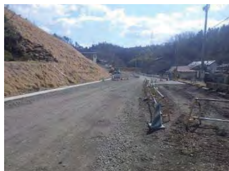
⑤ 平成31年3月 現在 施工中
