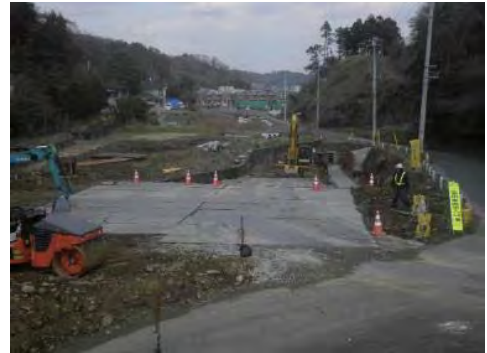
③ 平成31年3月 施工中
