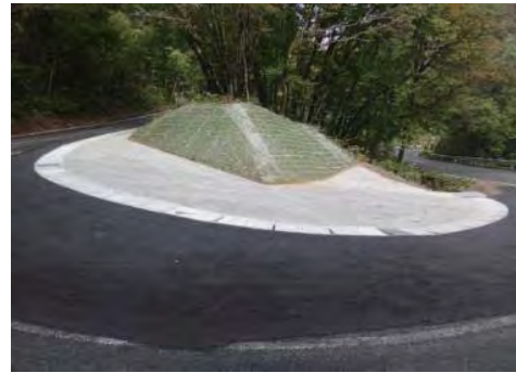
⑨ 平成30年11月 施工中 (道路拡幅完了(舗装除く))
