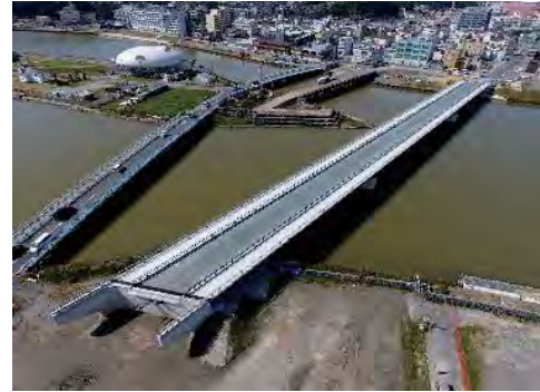
③ 平成30年10月 上部工工事完成
