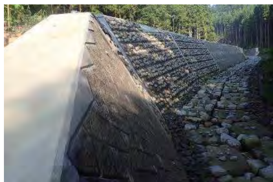
新川護岸工(附帯工事)の写真
