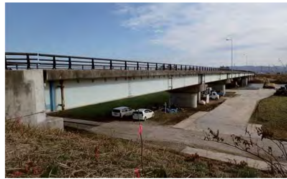
⑧ 登米市豊里町上谷地地内 (一)瀬峰豊里線 十五貫橋橋梁耐震補強工事
