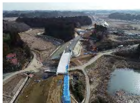
② 平成30年11月 施工中（上部桁架設完了）
