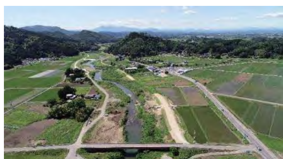
① 雉子尾川 丸森町大内地内 河川改修事業（樋管）
