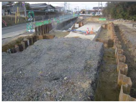
⑬ 平成31年2月 施工中 (函渠敷設完了)
