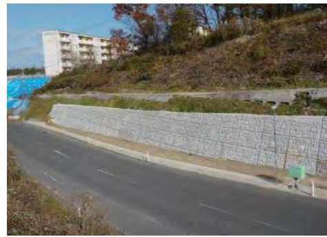
⑪ 平成30年11月 施工中 (擁壁工施工中)
