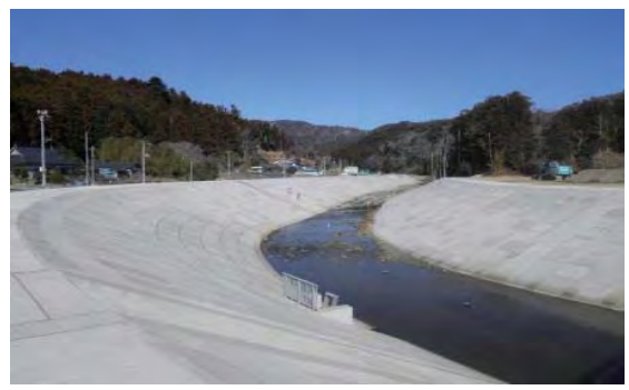
⑥ 平成31年2月末 現在 施工中
