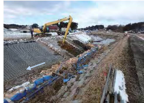
④ 平成31年2月 施工中（護岸工施工中）
