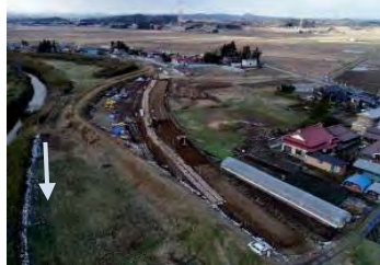
二迫川(築館沖富地区)築堤状況
