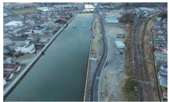
⑨ 平成31年2月 施工中
