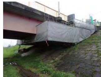
【及川橋耐震補強(石巻市)】
