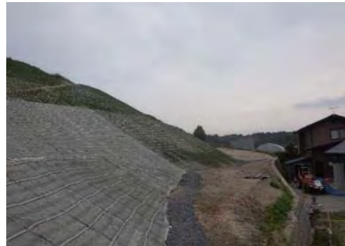
① 平成30年5月 完 成
