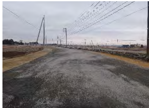
③ 平成31年2月 施工中 (路盤工完了)
