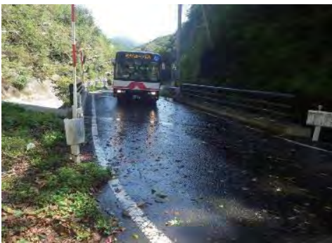
⑩ (主) 築館栗駒公園線 栗原市栗駒沼倉地内 柳沢道路改良
