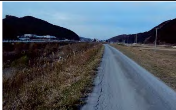
① 登米市津山町横山字北沢上地内 南沢川河道掘削工事
