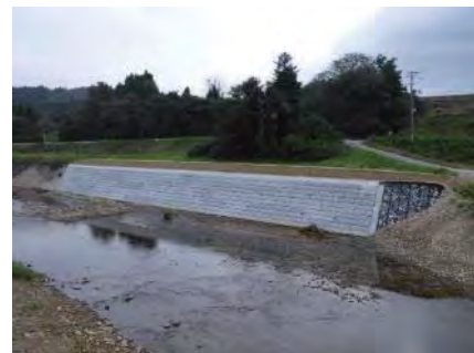
平成 29 年災 新堀川河川災害復旧事業
