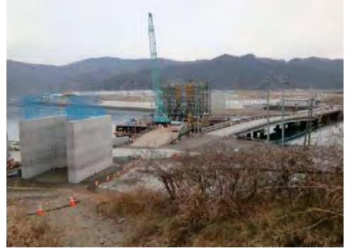
⑨ 平成31年2月 現在 本復旧（下部工） 施工中
