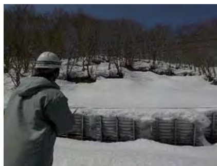
職員による斜面点検状況
