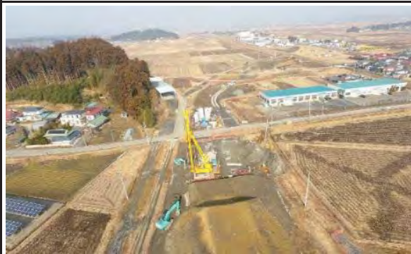
⑦ 平成31年3月 現在 地盤改良施工中
