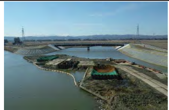
⑯ 平成31年2月 施工中
