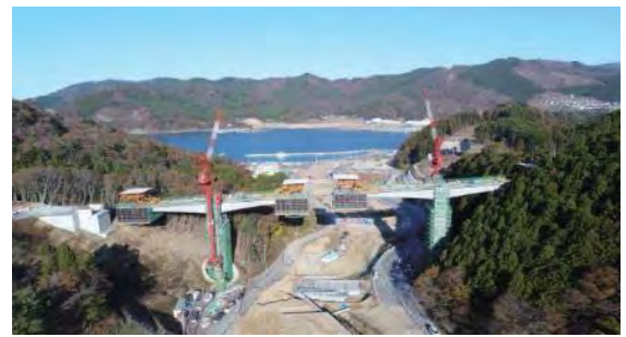
⑬ 平成30年12月 現在 上部工施工中
