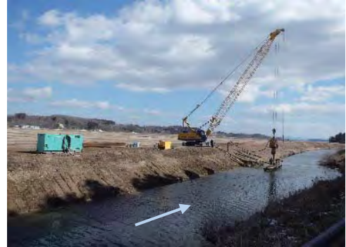
③ 平成31年2月 施工中（仮設工施工中）
