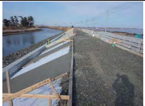
⑦ 平成31年3月 施工中
