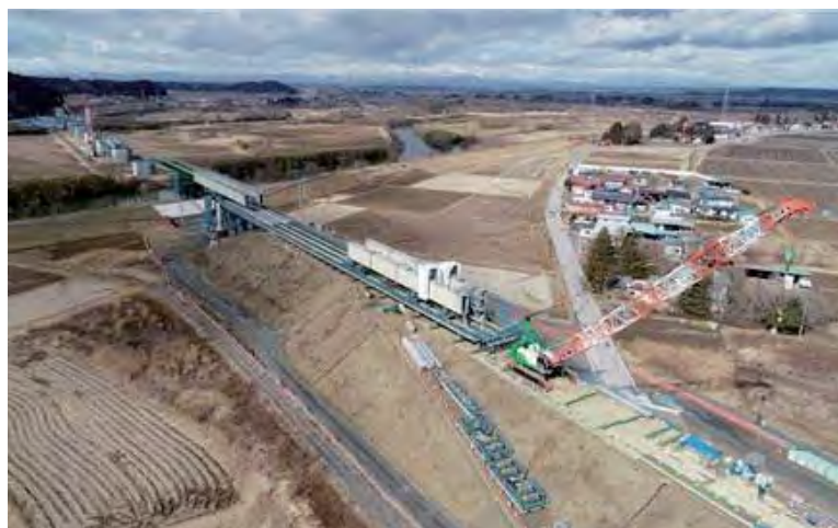
みやぎ県北高速幹線道路Ⅲ期佐沼工区 紫雲山大橋上部工施工中（平成 31 年 3 月）
