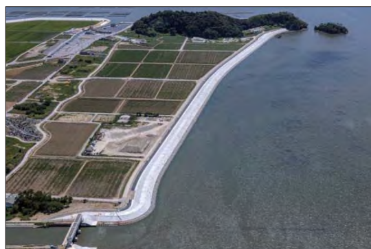
長浜地先海岸災害復旧(完成)
