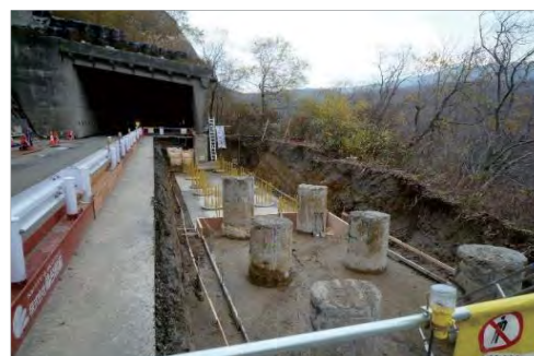
湯浜1号スノーシェッド延伸部の下部工施工状況
