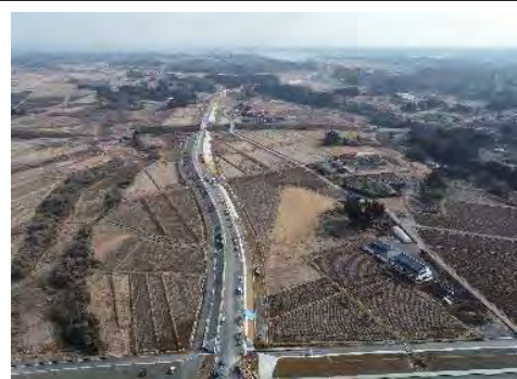
① 平成30年12月 施工中（路盤工施工中）
