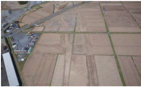
⑤ 登米市中田町石森字新境堀地内 みやぎ県北道路（佐沼工区）
