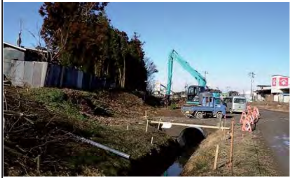
③ 平成31年2月 現在 排水路付替工 施工中
