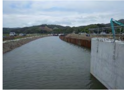
⑭ 平成31年2月 現在 本復旧 施工中
