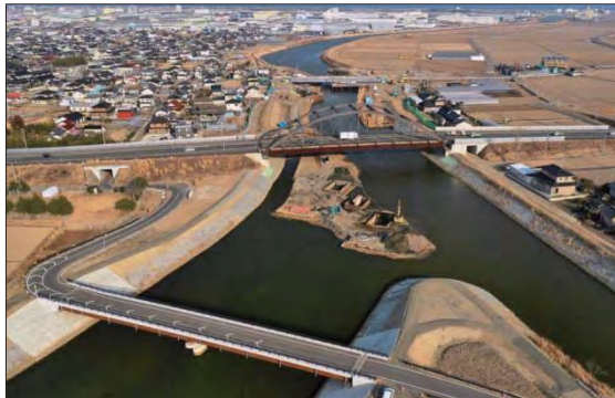
五間堀川河川改修(施工中)
