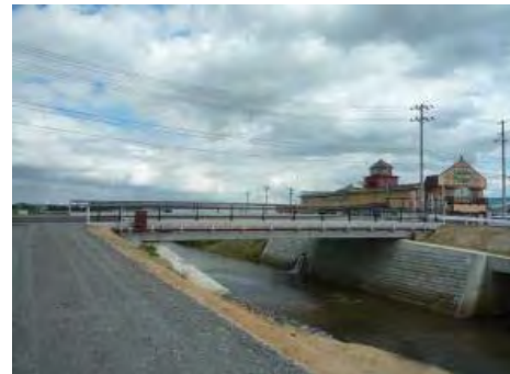
⑭ 平成30年6月 完 成
