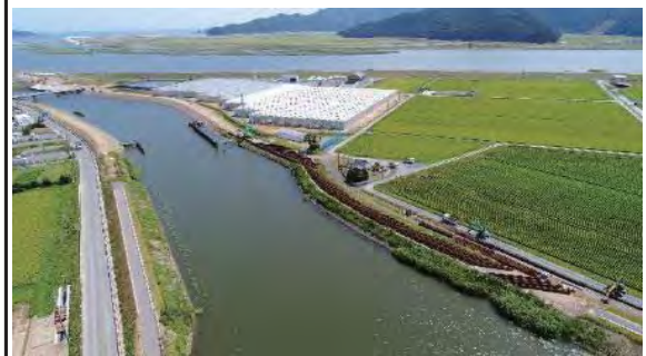
⑮ 平成31年2月 現在 本復旧 施工中
