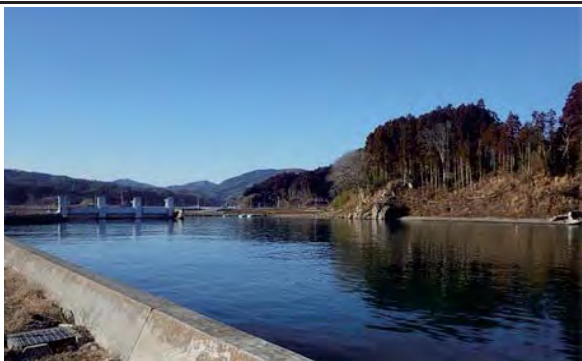
⑤ 本吉郡南三陸町戸倉字水戸辺地内外 水戸辺川河川外災害復旧工事
