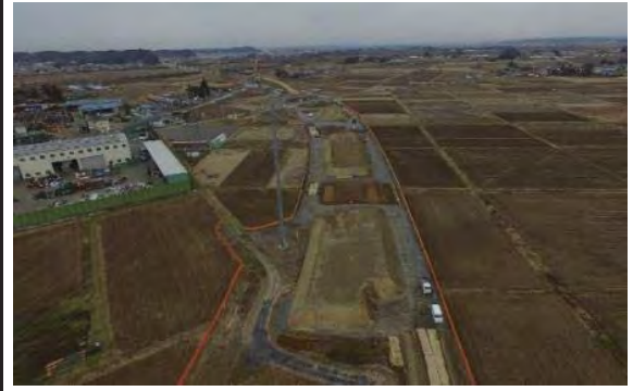
⑤ 平成31年3月 現在 地盤改良施工中
