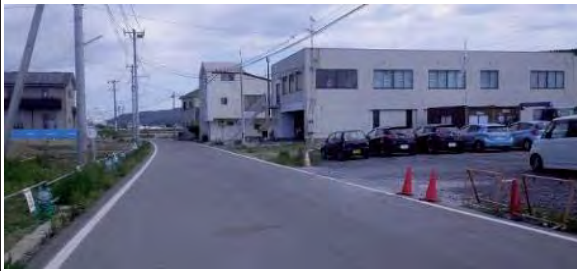
④ 大街道石巻港線 石巻市門脇町地内 着工前
