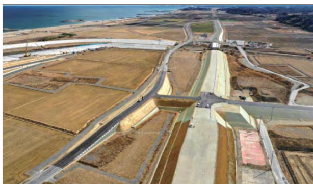
(主)相馬亘理線坂元工区(施工中)
