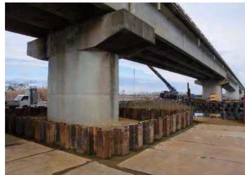
⑪ 平成30年3月 施工中
