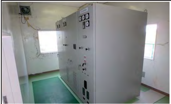
④ 平成30年11月 現在 完成
