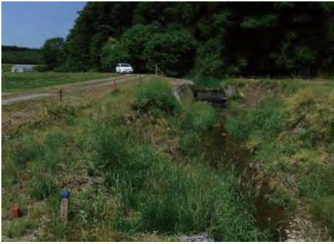
③ 二級河川高城川水系広長川 大崎市鹿島台広長地内 広長川河川災害復旧工事 (H29災)
