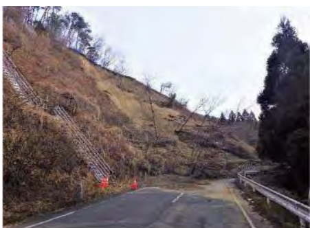
③ (一) 金山新地停車場線 丸森町大内地内 道路災害復旧事業
