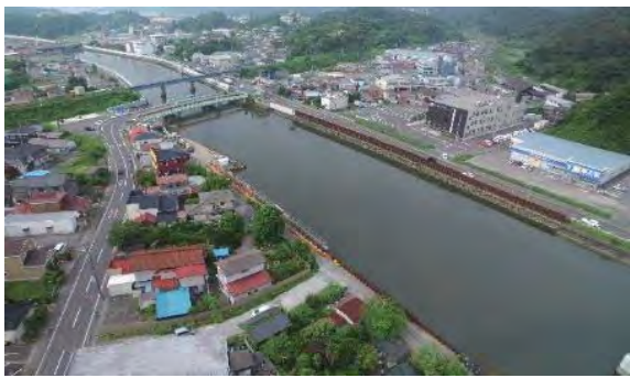
⑨ (一) 高城停車場線外 松島町高城地内外 松島橋橋梁災害復旧事業
