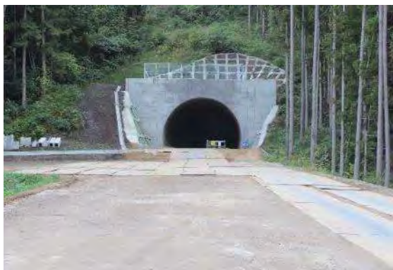
起点坑口(岩沼側)とトンネル坑内の写真
