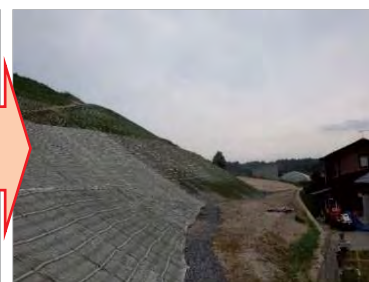
斜面对策完了後
