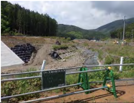
⑫ 雄勝復興道路 石巻市雄勝町雄勝地内 雄勝3号橋着工前
