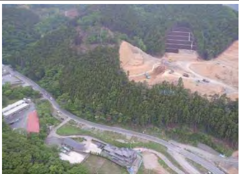
⑬ 牡鹿郡女川町小乗浜地内 着工前
