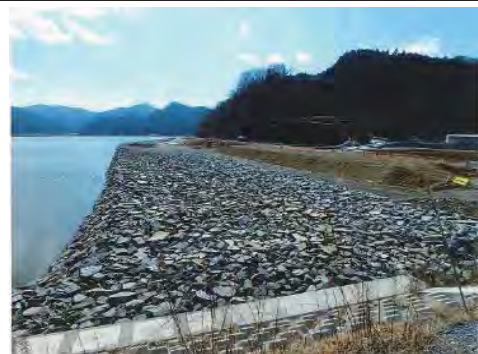
⑫ 平成31年2月 現在 施工中
