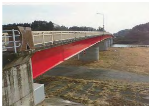
国道 346 号 感恩橋橋梁耐震補強工事
