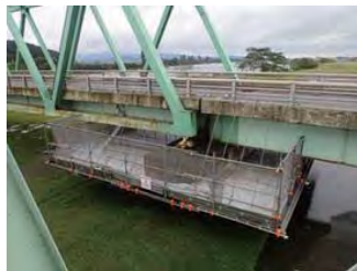
【神取橋耐震補強(石巻市)】
