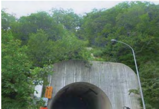
④ (国) 108号 大崎市鳴子温泉鬼首字軍沢地内 軍沢災害防除工事
