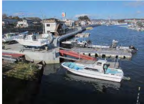
⑬ 平成30年12月 一部完成
