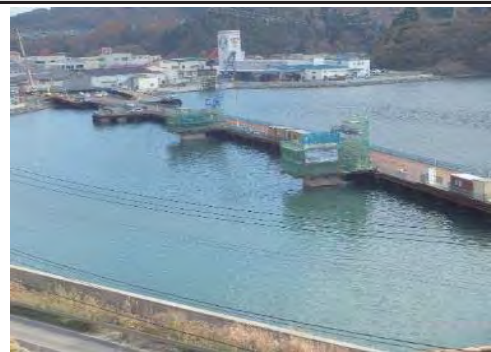
⑭ 平成30年12月 現在 上部工施工中
