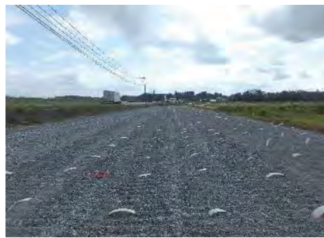
⑧ 平成30年10月 施工中 (地盤改良完了)
