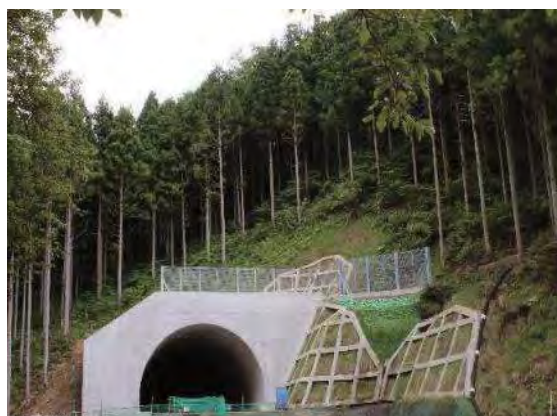
終点坑口(村田側)と姥ヶ森山橋下部工の写真
