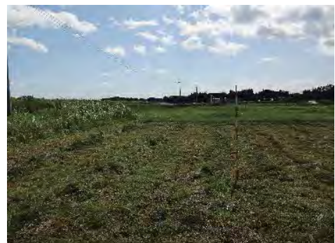
⑧ (主) 築館登米線 栗原市築館萩沢地内 萩沢道路改良
