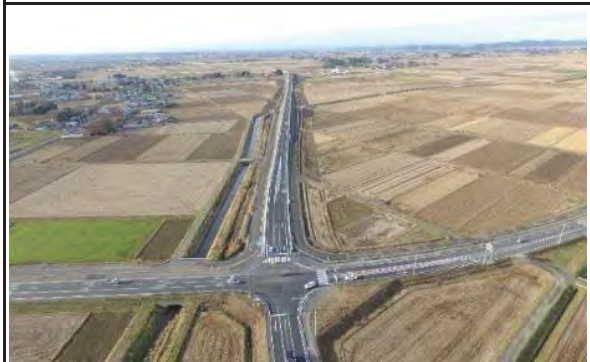
③ 平成30年12月 現在 完成 12月25日供用開始
