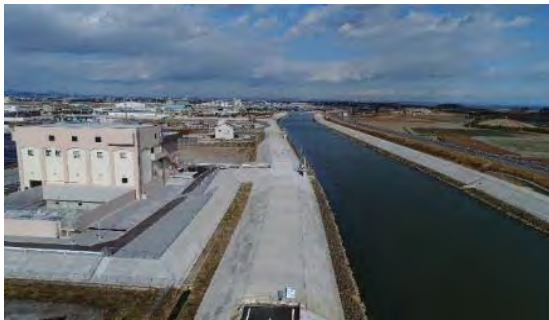
④一級河川名取川水系南貞山運河 岩沼市下野郷地内 河川災害復旧事業
