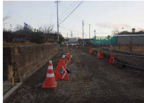
① 令和2年3月 施工中
