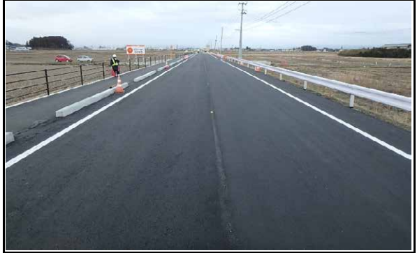
⑩ 令和2年3月現在 舗装工 施工中
