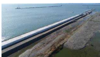
石巻港雲雀野地区工事
