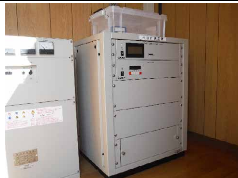
② 令和元年11月 完成
