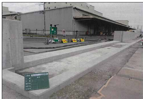
⑮ 仙塩釜港（仙台港区）仙台市宮城野区港四丁目地内外 仙塩釜港防潮堤陸開外（その2）工事
