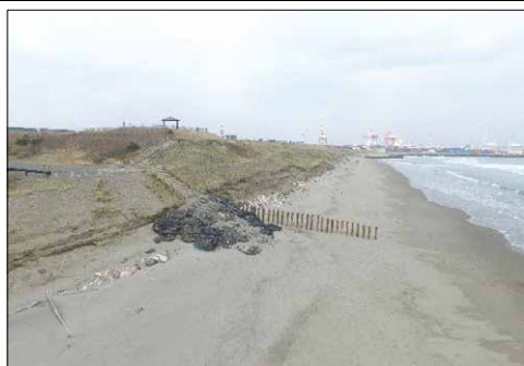
⑰ 仙塩釜港（仙台港区）仙台市宮城野区港四丁目地内外 向洋地区防潮堤工事
