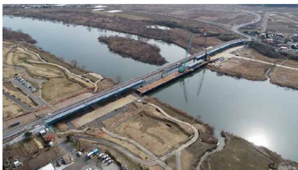
豊里大橋橋梁耐震補強外工事施工状況（令和 2 年 2 月）
