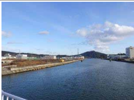
④ 大川 気仙沼市 大川外河川災害復旧工事
