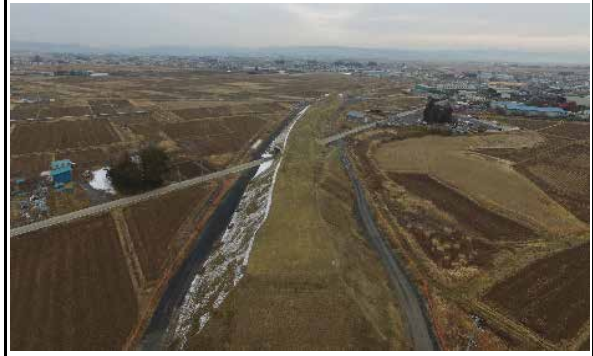
⑤ 令和2年3月 現在 施工中
