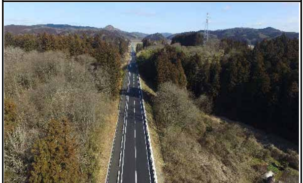
⑧ 令和2年3月 現在 完成 3月7日供用開始
