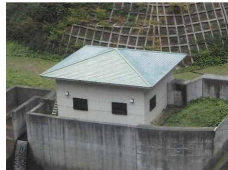
⑤ 令和元年11月18日 完成
