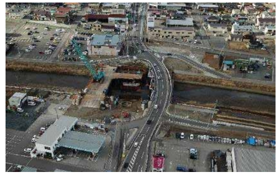
⑤ 令和2年3月 仮橋完了，旧橋撤去施工中
