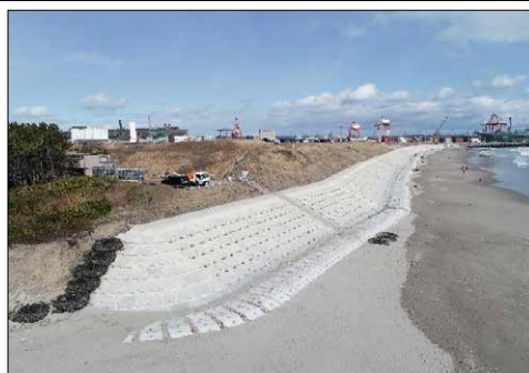
⑰ 令和2年3月 完成
