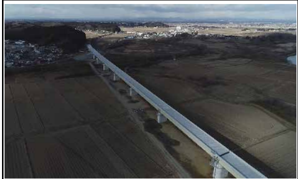
⑥ 令和2年3月 現在 施工中
