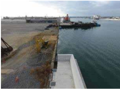
⑨ 仙台塩釜港石巻港区海岸西浜南浜地区 石巻市西浜町地内 西水路南地区潮堤（その6）外工事
