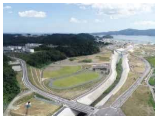
国道 398 号志津川復興道路 完了 (令和元年 6 月 28 日供用開始)
