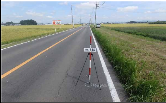
⑩ 登米市南方町後屋敷待井地内 (主) 古川佐沼線 板倉自歩道設置工事
