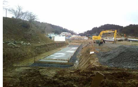
⑪ 令和2年3月 現在 施工中
