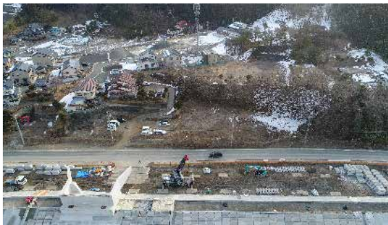
① (一) 大島浪板線 気仙沼市浪板地内 浪板橋付近
