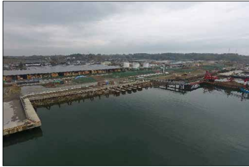
⑨ 仙台塩釜港（塩釜港区）七ヶ浜町東宮浜字笠岩地内 東宮ふ頭さん橋改良工事（その3）
