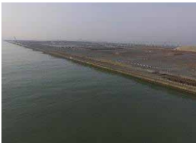
⑦ 仙台塩釜港石巻港区海岸雲雀野地区 石巻市雲雀野町地内 雲雀野地区防潮堤（その5）工事
