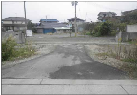
⑩ 仙台塩釜港（塩釜港区）七ヶ浜町東宮浜字笠岩地先 東宮浜胸壁（陸閘）災害復旧外工事
