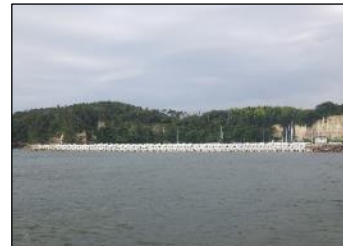
小浜(B)防潮堤消波ブロック設置工事 (塩釜港区)
