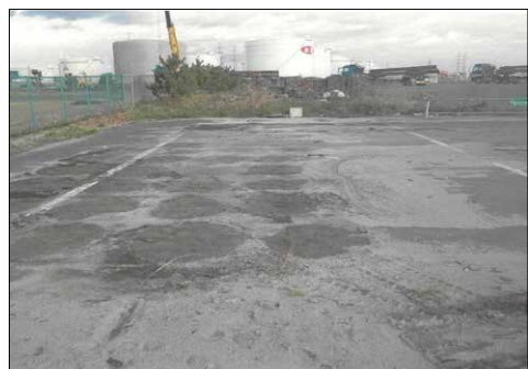
⑯ 仙塩釜港（仙台港区）仙台市宮城野区港四丁目地内外 仙塩釜港陸開被制御局上屋新築工事
