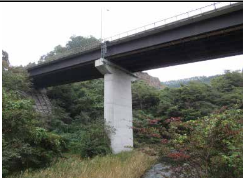
① (国) 284号 猿岩橋 気仙沼市切通地内 着工前
