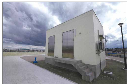
⑪ 令和元年7月 完成
