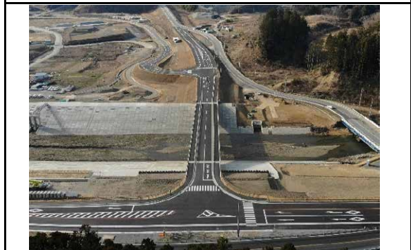
⑤ 令和2年3月 完成
