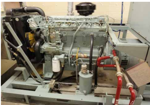
④ 大崎地方ダム総合事務所 加美町城生字前田地内 堰堤改良事業／非常用電源設備改良工事
