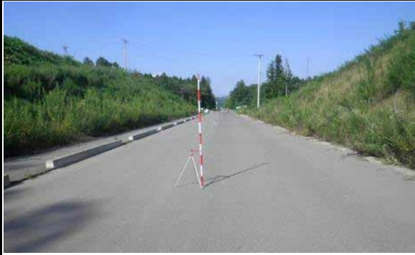
⑧ 登米市東和町錦織地内 (国) 346号 錦織道路改良工事 (その1)
