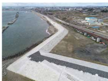
石巻港東浜防潮堤災害復旧工事
