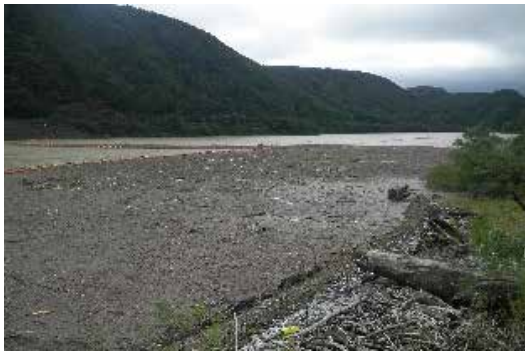
③ 漆沢ダム 加美町字漆沢宮ヶ森地内 災害復旧事業／流木外災害復旧工
