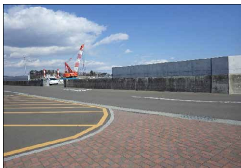
⑦ 仙台塩釜港（塩釜港区）七ヶ浜町東宮浜要害地先外 要害浦胸壁（陸閘）災害復旧外工事
