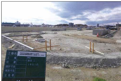
⑪ 仙台塩釜港（塩釜港区）七ヶ浜町東宮浜字笠岩地内外 塩釜港区陸閘被制御局上屋新築工事（その2）
