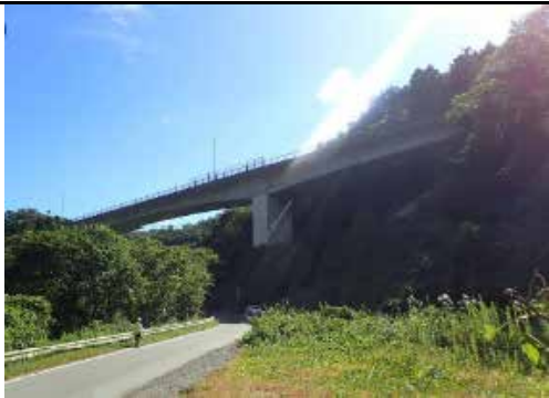
② (国) 284号 山びこ大橋 気仙沼市下八瀬地内 着工前
