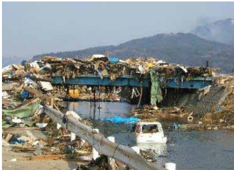
④ (主) 気仙沼唐桑線 気仙沼市松崎方浜地内 災害復旧事業／道路災・橋梁災／松崎方浜・面瀬橋
