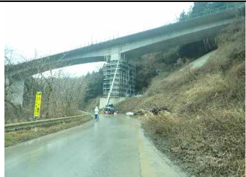
② 令和2年3月 施工中
