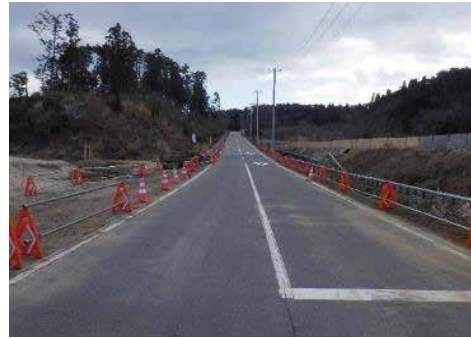
③ 令和2年3月 施工中
