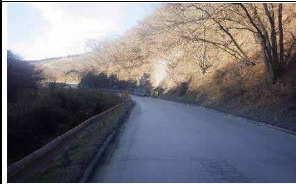
⑪ 登米市登米町大字日根牛地内 (一) 志津川登米線 下羽沢災害防除工事
