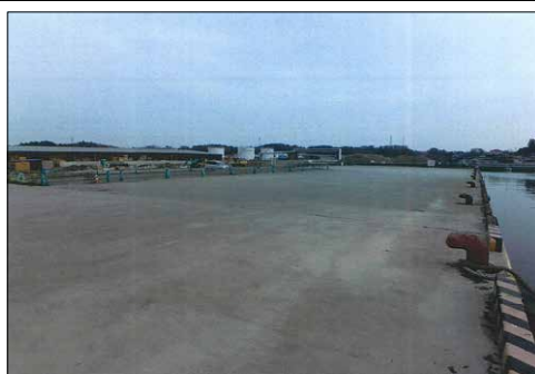
⑧ 仙台塩釜港（塩釜港区）七ヶ浜町東宮浜字笠岩地先 東宮ふ頭さん橋改良外工事（その1）
