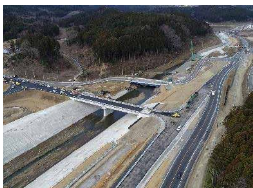
折立橋(完成)・折立川(施工中)
