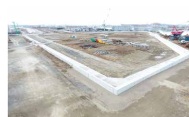
石巻港西水路南地区工事
