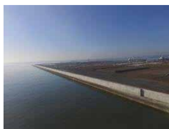
石巻港雲雀野地区工事
