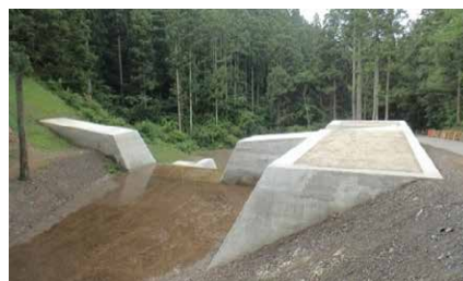
鍋割堰堤改築工事完成（令和元年6月）
