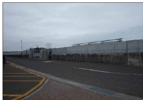
⑦ 令和2年3月 完成
