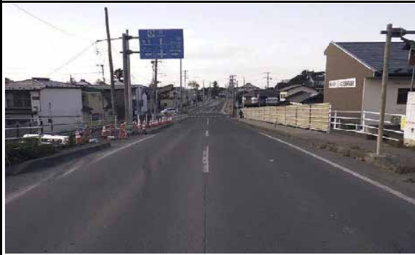
⑨ 登米市登米町寺池三日町地内 (主) 築館登米線外 寺池道路改良工事
