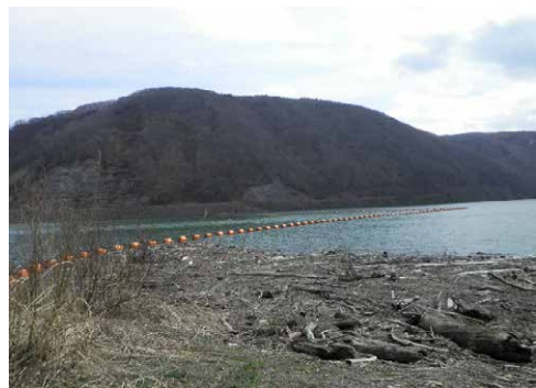
③ 漆沢ダム 令和2年4月7日 施工中
