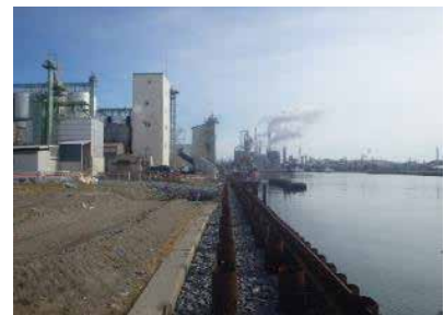
⑧ 令和2年3月 現在 施工中
