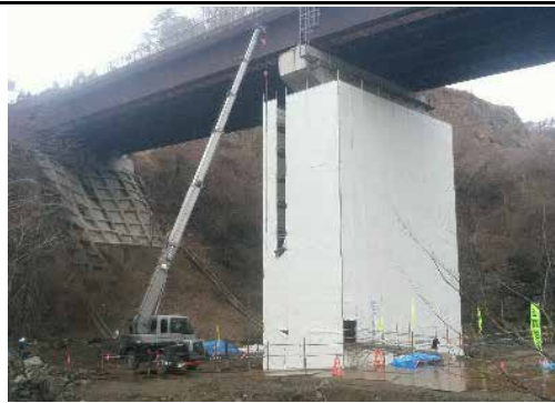
① 令和2年3月 施工中
