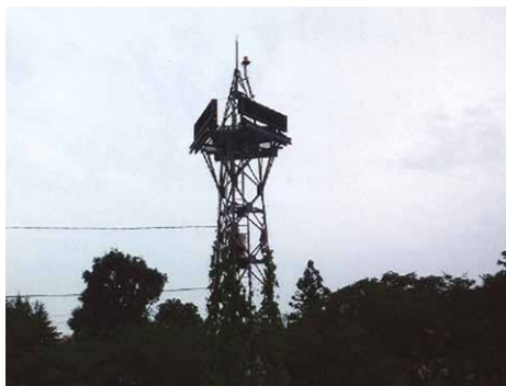
② 漆沢ダム 加美町字下川原地内 堰堤改良事業／上河原警報表示板更新工
