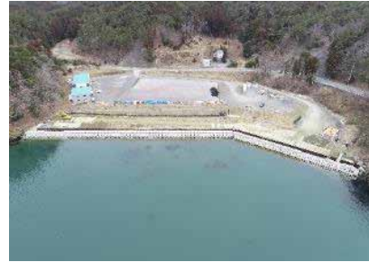
⑩ 令和2年3月 現在 施工中
