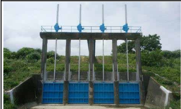
④ 令和元年9月 現在 完成
