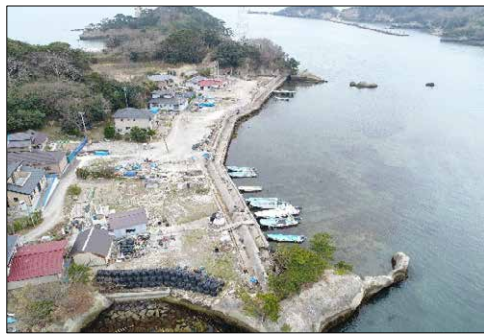
① 仙台塩釜港（塩釜港区）塩竈市浦戸野々島毛無崎地内 毛無崎胸壁外災害復旧工事
