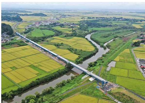
佐沼工区「紫雲山大橋」施工状況（令和元年 9 月）
