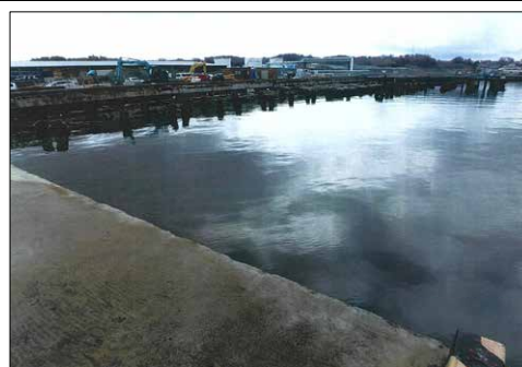
⑧ 平成31年4月 さん橋床版撤去完了
