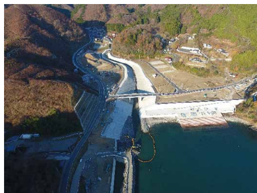
只越川・只越橋 完成
