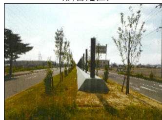
津波漂流物対策施設(中央幹線) (仙台港区)
