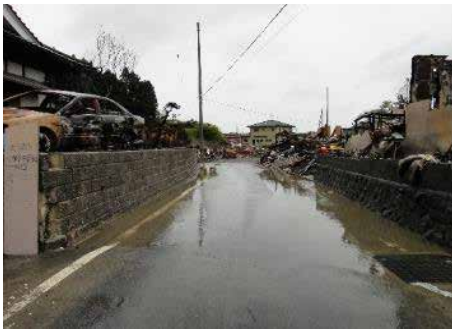
① (一) 大島浪板線 気仙沼市小々汐地内 災害復旧事業／路面災／小々汐
