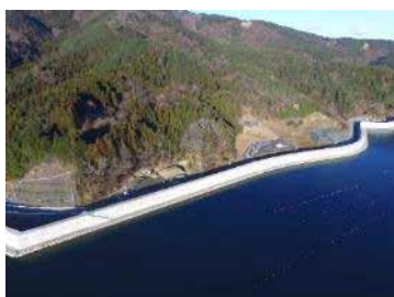
雄勝港伊勢畑防潮堤災害復旧工事
