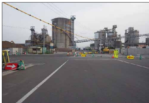
⑥ 仙台塩釜港（塩釜港区）塩竈市貞山一丁目地内 貞山ふ頭防潮堤（陸閘）工事（その3）
