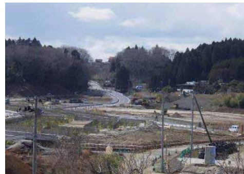
② 令和2年3月 施工中
