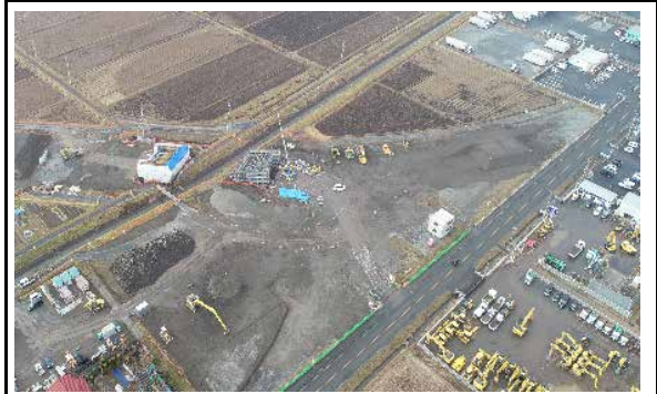
⑦ 令和2年3月 現在 施工中
