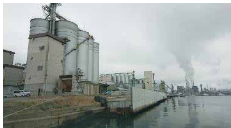
⑧ 仙台塩釜港石巻港区海岸釜地区 石巻市三河町地内 日和地区防潮堤（その2）工事
