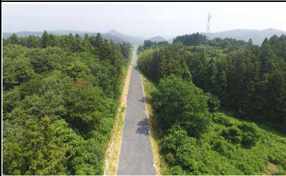
⑧ 登米市東和町錦織地内 (国) 346号 錦織道路改良工事 (その2)
