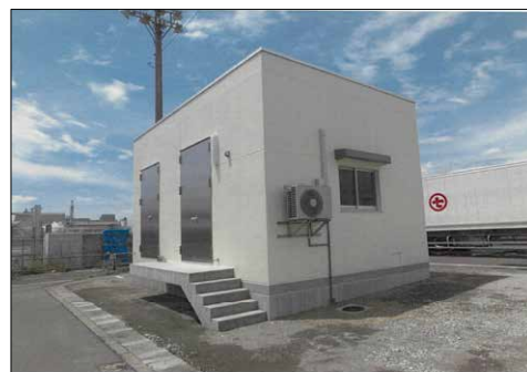
⑯ 令和元年7月 完成
