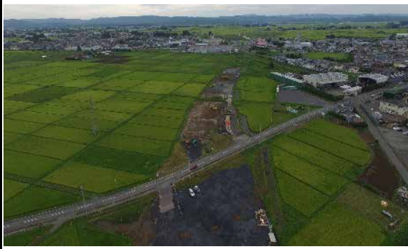
⑤ みやぎ県北高速幹線道路Ⅲ期（佐沼工区） 平成30年8月撮影
