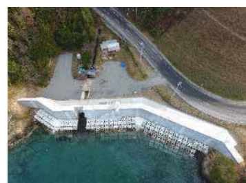
雄勝港立浜防潮堤災害復旧工事
