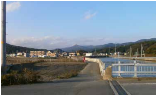
③ 鹿折川 気仙沼市 鹿折川河川災害復旧工事
