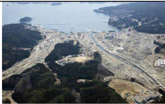
① 国道398号 南三陸町志津川字御前下地内 志津川復興道路事業
