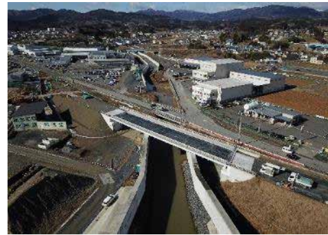
④ 令和2年3月 施工中
