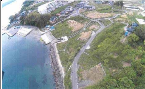
③ 清水浜志津川港線 南三陸町志津川字平磯地内 清水浜荒砥道路復興事業
