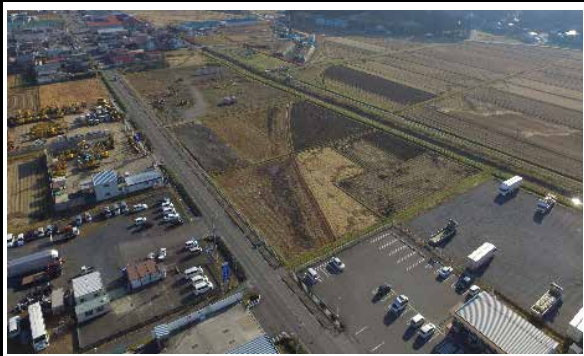
⑦ みやぎ県北高速幹線道路Ⅲ期（佐沼工区） 平成29年2月撮影 起点部
