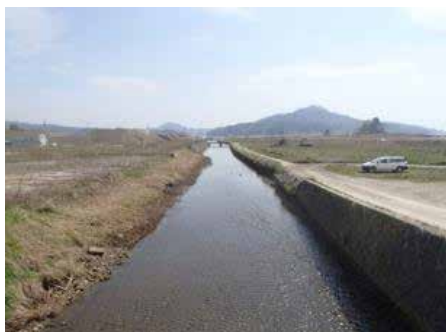
⑤ 面瀬川 気仙沼市 面瀬川河川災害復旧工事
