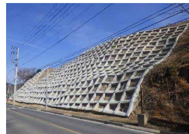
【給分浜 道路路面災害防除工事】
