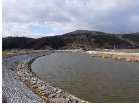
③ 令和2年3月 現在 施工中
