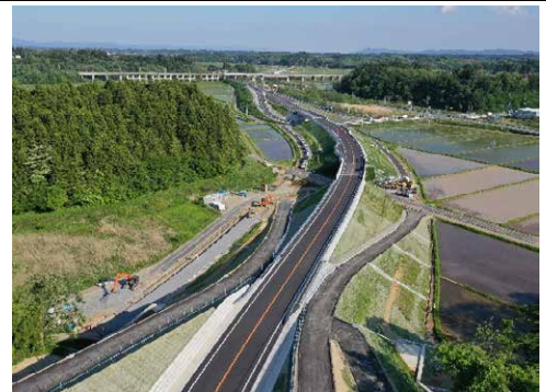
② 令和元年6月 供用開始（完成）
