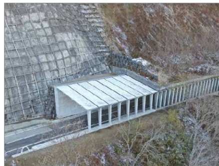
湯浜1号スノーシェッド延伸部施工状況
