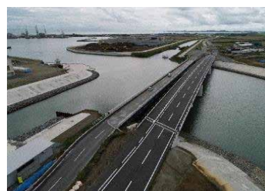
【大曲道路災害復旧(東松島市)】
