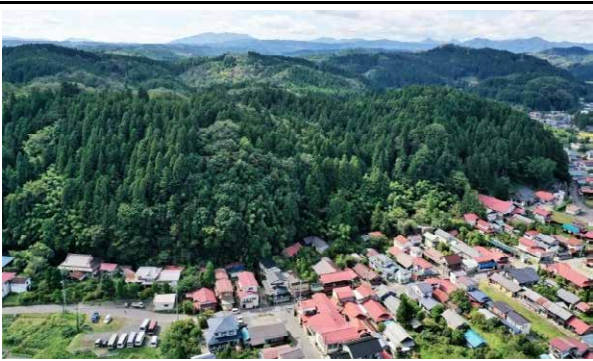
② 川口 栗原市一迫川口地内 川口急傾斜地崩壊対策
