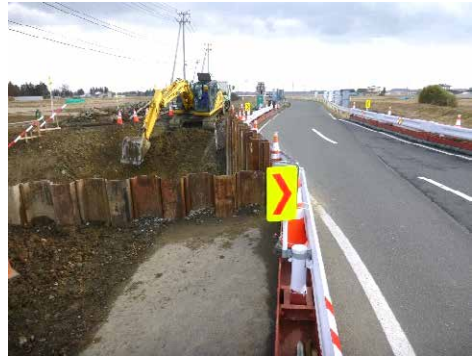
③ 令和2年1月 施工中 (排水樋管施工中)
