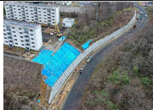
⑦ 令和元年12月 施工中（擁壁工施工中）
