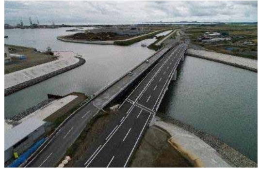
③ 令和元年10月 現在 本橋供用（仮橋撤去中）
