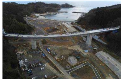
⑦ 令和2年3月 現在 本工事施工中（相川3号橋周辺）
