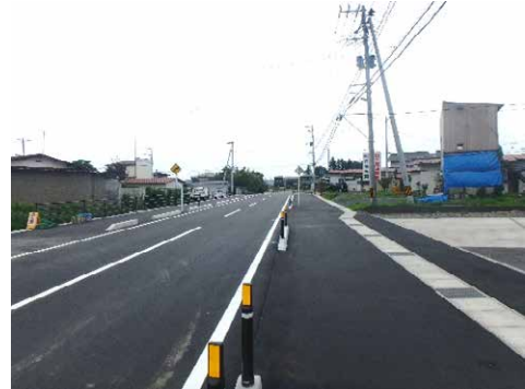
⑨ 令和元年8月 供用開始(完成)
