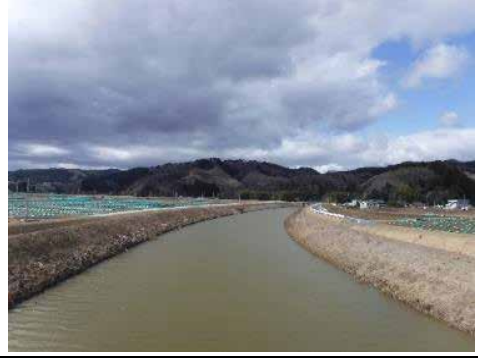
⑨ 令和2年3月 現在 本復旧 施工中
