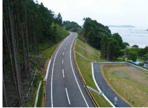
④ 令和元年7月9日 完成
