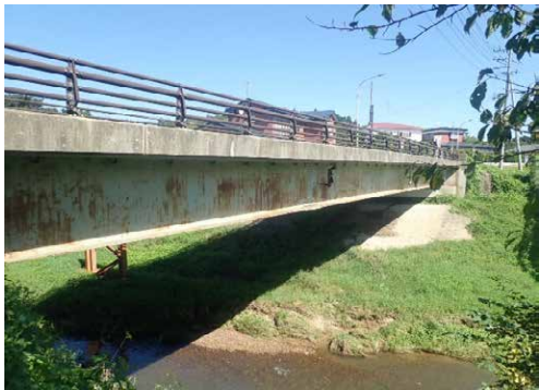
⑩ (主) 中田栗駒線 栗原市栗駒里谷地内 杉橋橋梁補修
