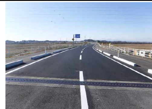
⑧ 令和元年12月 完成
