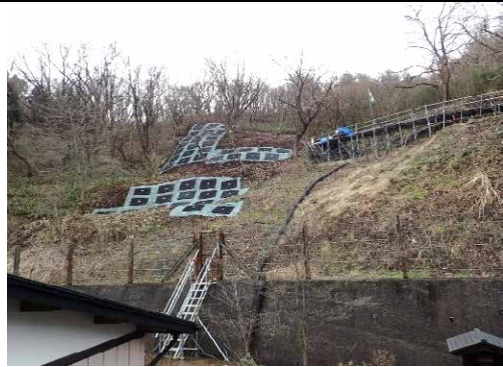
① 令和2年2月 施工中（法面对策施工中）
