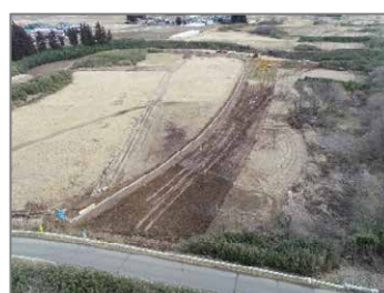
二迫川(栗駒桜田地区)築堤状況
