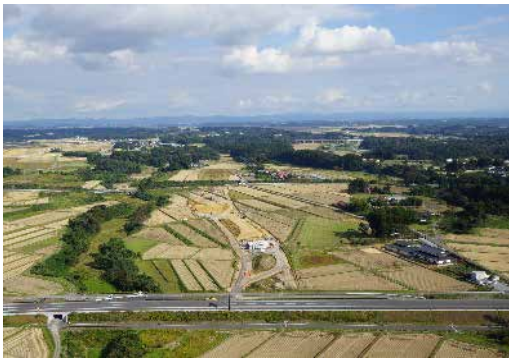
① みやぎ県北高速幹線道路 栗原市築館萩沢後沢地内 国道4号築館バイパス接続
