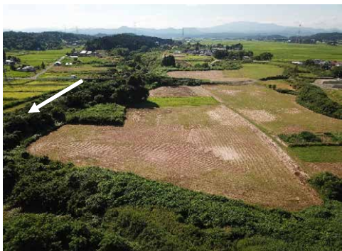
② 二迫川 栗原市栗駒桜田下袋地内 迫川（二迫川工区）河川改修
