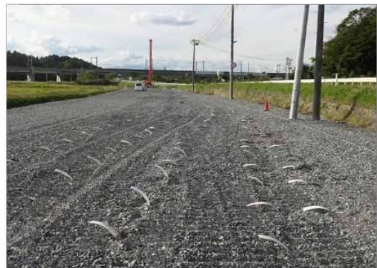
築堤工(地盤改良)の施工状況
