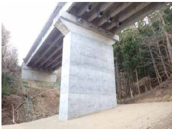
【水浜橋耐震補強工事 完成】
