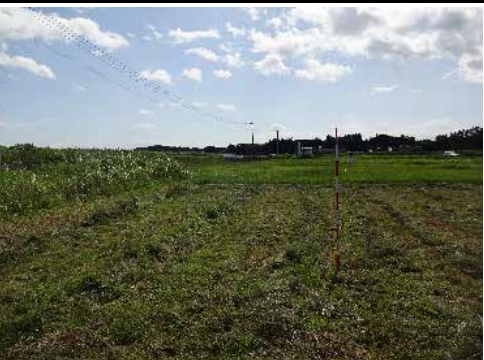
⑤ (主) 築館登米線 栗原市築館萩沢地内 萩沢道路改良
