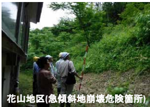
花山地区(急傾斜地崩壊危険箇所)
