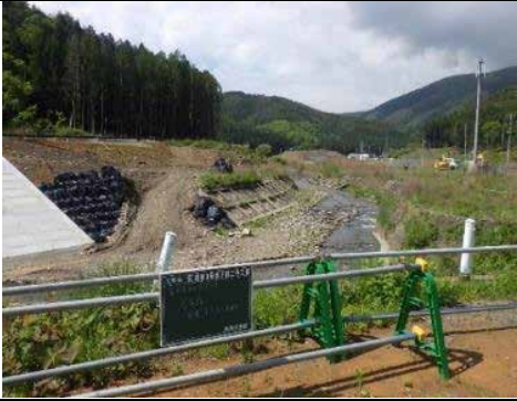
⑨ 雄勝復興道路 石巻市雄勝町雄勝地内 雄勝3号橋着工前
