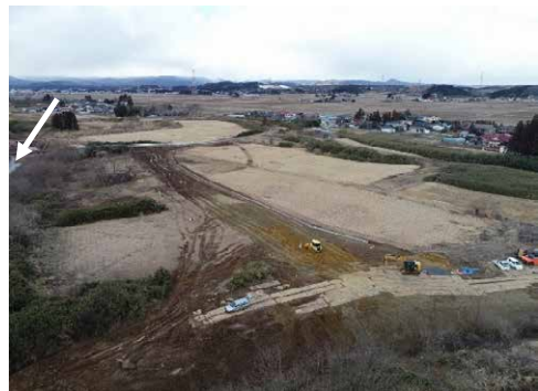
② 令和2年2月 施工中（築堤施工中）
