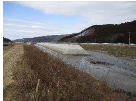
⑪ 令和2年3月 現在 本復旧 施工中
