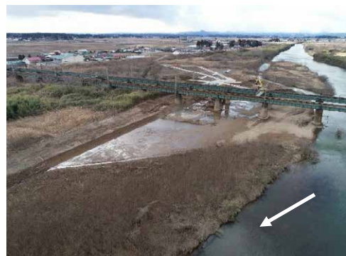
① 令和2年2月 施工中（河道掘削施工中）
