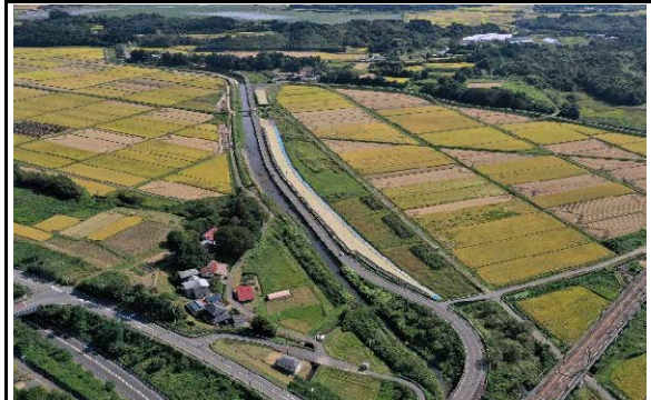
⑤ 令和2年1月 施工中 (地盤改良圧密沈下促進中)
