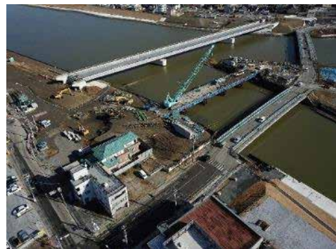
② 令和2年3月 現在 上部工 完成
