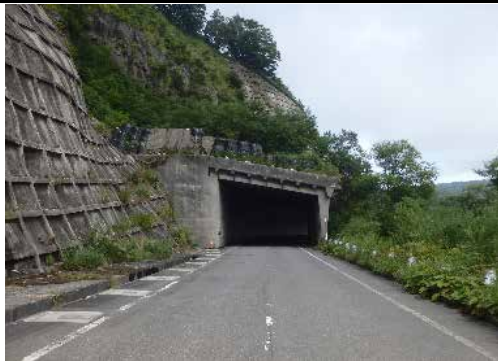
④ 国道398号 栗原市花山湯浜地内 湯浜1号スノーシェッド
