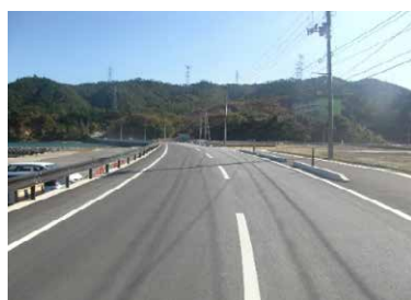
【野々浜道路災害復旧(女川町)】
