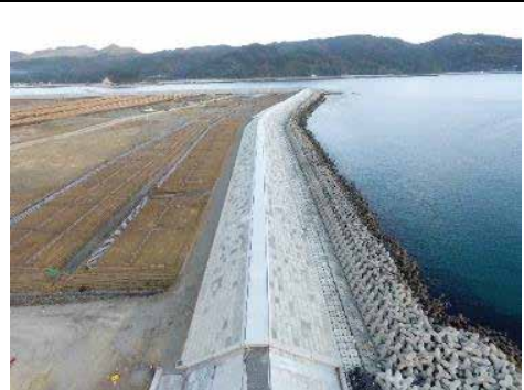
⑧ 令和2年3月 現在 施工中
