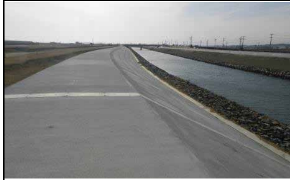
② 令和2年3月 現在 法覆護岸工 施工中
