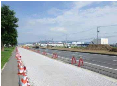
① (都) 門脇流留線 石巻市魚町 着工前
