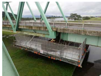
【神取橋耐震補強 施工中】
