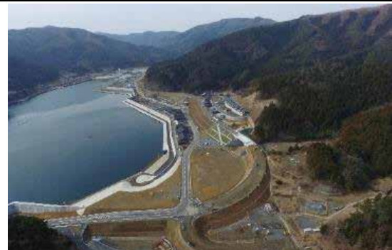
⑧ 令和2年3月 現在 本工事施工中
