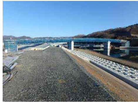
⑥ 令和2年3月 現在 本復旧（上部工） 施工中
