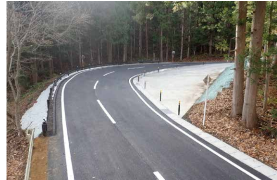
⑥ 令和元年11月 施工中（道路拡幅部分完了）
