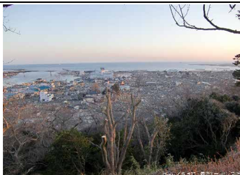
② 南浜津波復興記念公園 石巻市南浜地内 着工前
