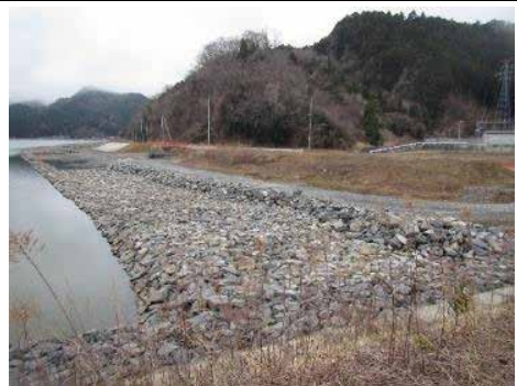
⑦ 令和2年3月 現在 施工中
