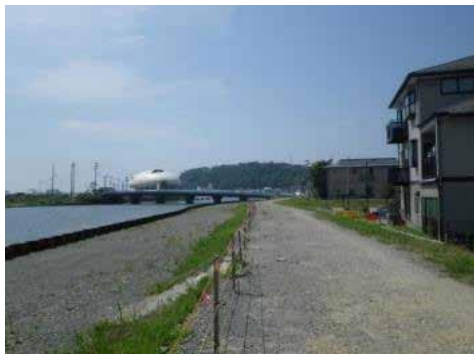
② 内海橋災害復旧 石巻市中央地内 着工前
