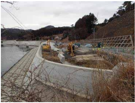
⑤ 令和2年3月 現在 施工中
