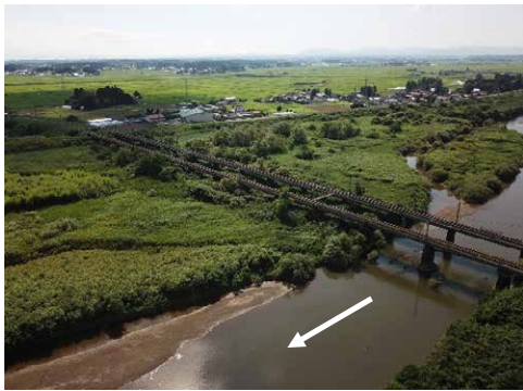
① 迫川 栗原市若柳字川南土手外地内 迫川（若柳工区）河川改修
