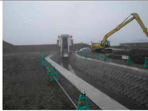
⑥ 令和2年3月 現在 施工中
