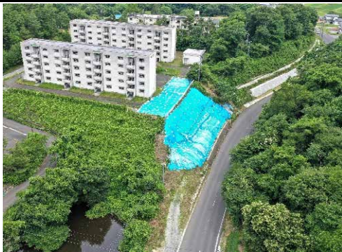
⑦ (主) 河南築館線 栗原市築館萩沢土橋地内 萩沢土橋交通安全施設整備
