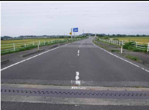
⑧ 国道398号 栗原市若柳川南地内 川南舗装補修
