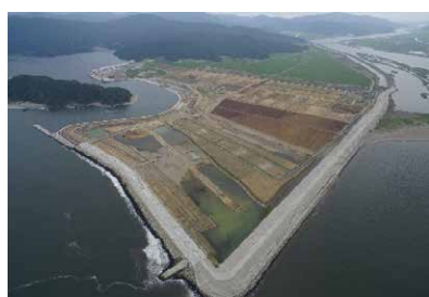
【横須賀地先海岸災害復旧(石巻市)】
