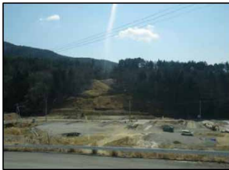
④ 小網倉浜復興道路 石巻市小網倉浜地内 着工前
