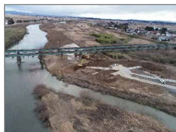
迫川(若柳大林地区)河道掘削状況
