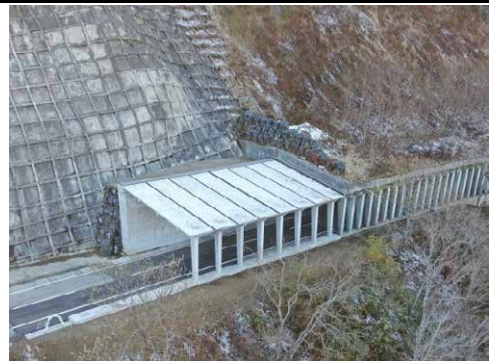
④ 令和元年12月 施工中 (上部工延伸)
