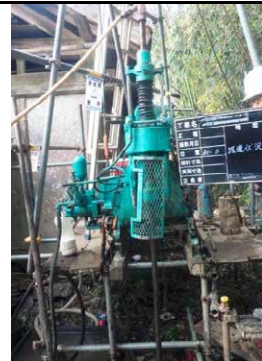
② 令和元年11月 調査中（ボーリング調査）
