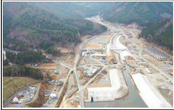
⑨ 令和2年3月 現在 本工事施工中
