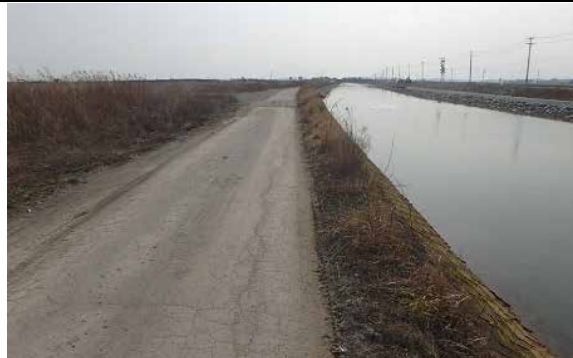
② 南北上運河 東松島市大曲地内 着工前
