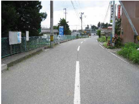
⑨ (主) 河南築館線 栗原市築館内沢地内 (都) 源光町田線 内沢道路改築
