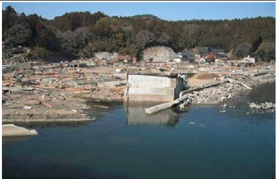
⑦ 相川復興道路 石巻市北上町十三浜字相川地内 橋梁上部工・取付道路流出状況
