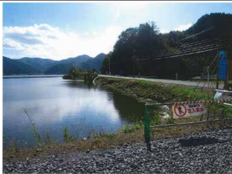
⑦ 一級河川北上川水系富士川 石巻市針岡地内 河川堤防・樋門整備
