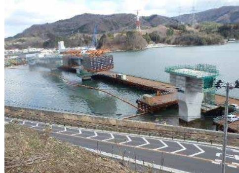
⑪ 令和2年3月 現在 上部工施工中
