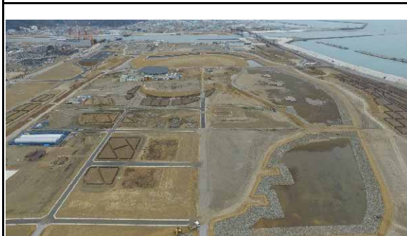
② 令和2年3月 現在 (造成工事完了)
