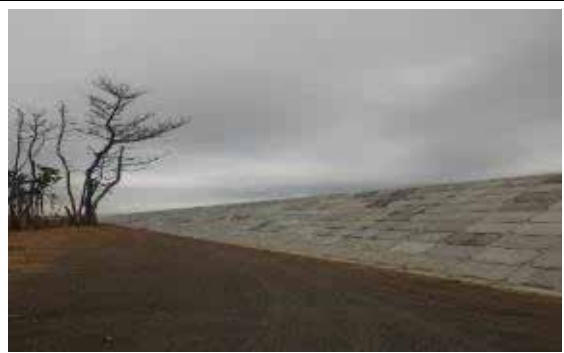
① 令和2年3月 現在 本復旧 施工中
