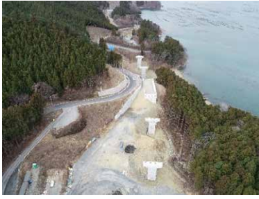
【風越(Ⅱ)道路改良(石巻市)】
