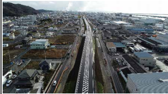
① 令和2年3月 現在 (魚町工区において部分供用開始)
