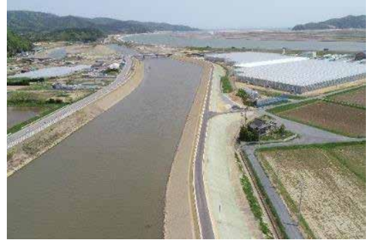
⑩ 令和2年3月 現在 本復旧 施工中
