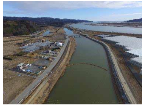
⑩ 311地震災第5020号 石巻市北上町橋浦 地内 皿貝川 河川堤防沈下
