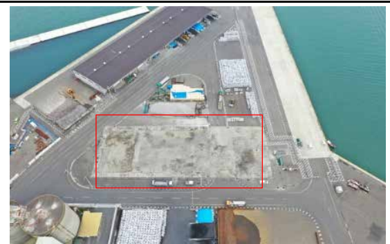
⑧ 令和2年3月 施工中 (2月着工時点と同様)
