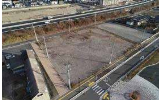
⑥ 令和元年11月28日 着工 石巻警察署新蛇田南待機宿舍新築工事 石巻市
