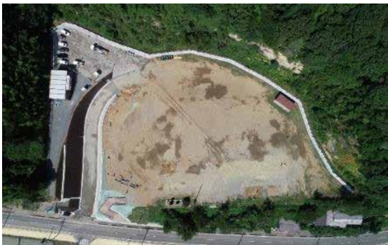
① 令和元年6月19日 着工 松島自然の家改築工事（第二期） 東松島市
