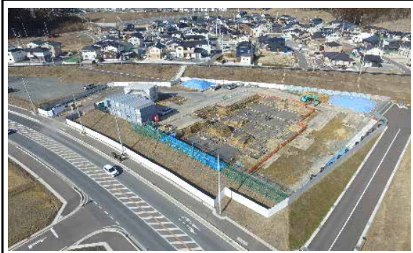
⑦ 令和2年3月 施工中
