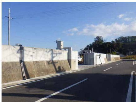
仙台塩釜港(塩釜港区) 東宮浜胸壁
