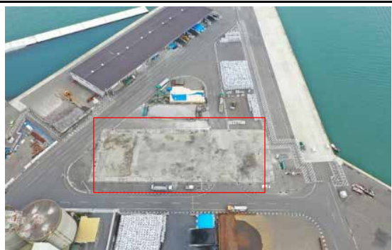
⑧ 令和2年2月15日 着工 塩釜港区貞山2号県営上屋新築工事 塩竈市
