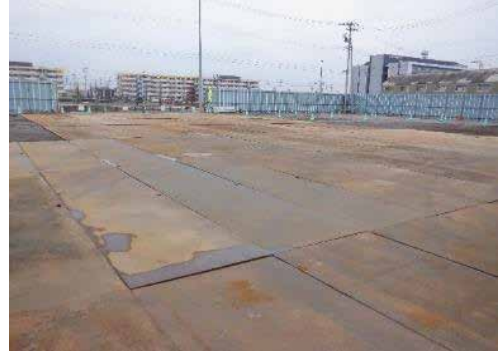
⑥ 令和元年11月15日 施工中
