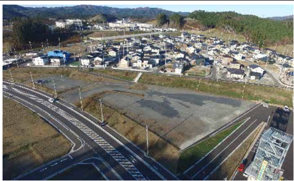
⑦ 令和元年11月28日 着工 南三陸警察署庁舎等新築工事 南三陸町
