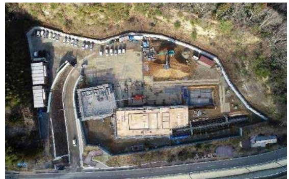
① 令和2年2月 施工中
