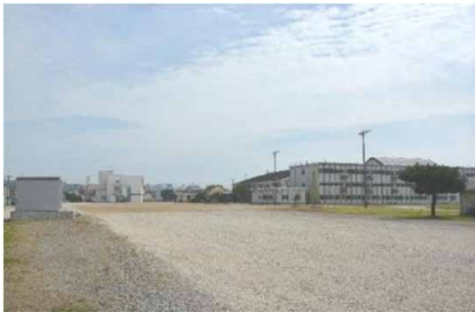
② 令和元年10月5日 着工 石巻好文館高校舎改築工事 石巻市
