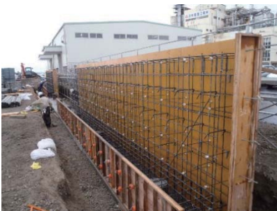
上部工型枠設置状況
