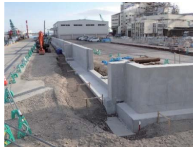
コンクリート打設完了
