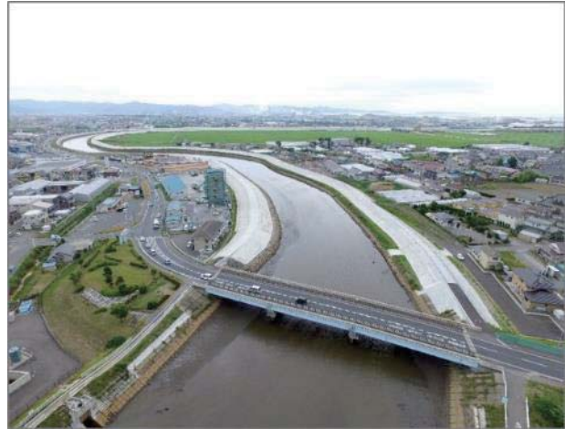
定川橋（国道45号）付近から下流を望む
