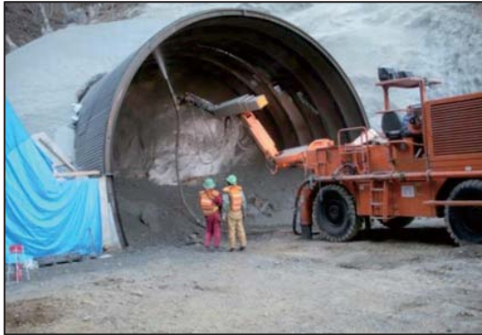
(写真1) トンネル抗口吹付工
