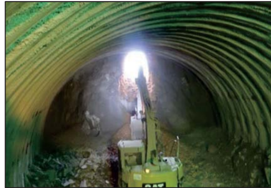
(写真2) トンネル貫通の瞬間
