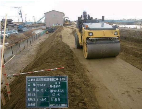
堤防盛土状況
