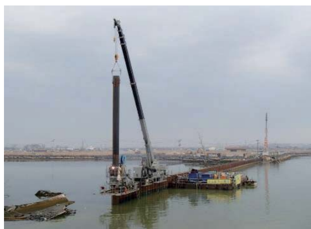
鋼管矢板打込状況
