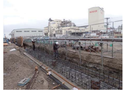
上部工配筋状況
