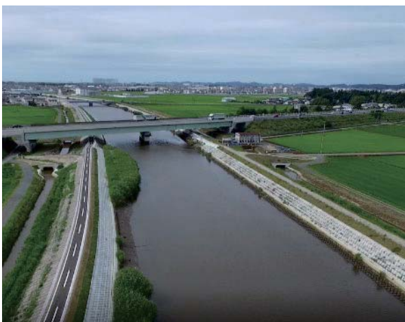
三陸自動車道上流から下流を望む
