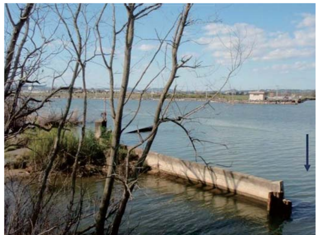
定川大橋上流部
