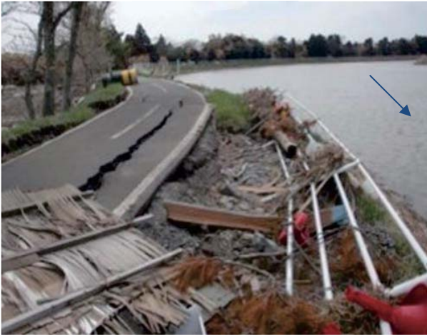
定川橋下流部
