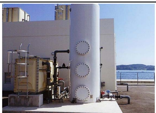
平成28年8月12日 完成 海水ろ過設備設置後
