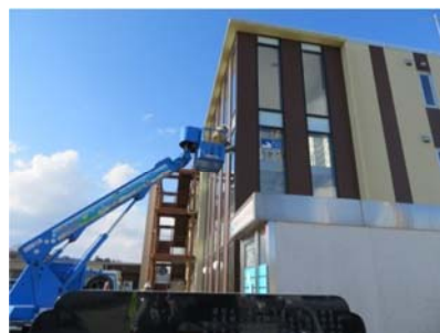
津波浸水表示板設置の様子
