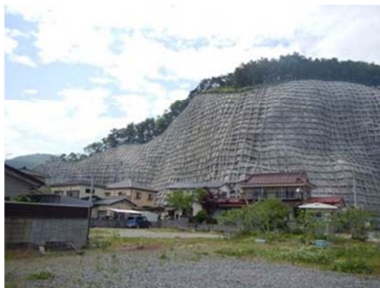
■鹿妻急傾斜地崩壊対策事業
