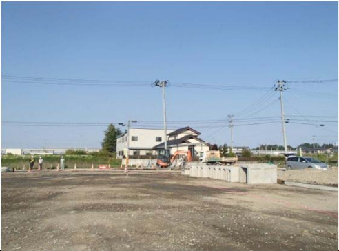
平成28年3月24日 着工 坂元道合地区災害公営住宅 山元町
