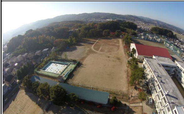
名取高校舎改築工事 岩沼市字朝日地内（平成27年10月 着工）
