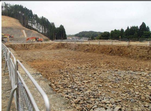
平成27年6月17日 着工
