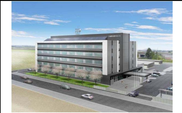
石巻合同庁舎新築工事 (平成30年1月 完成予定)
