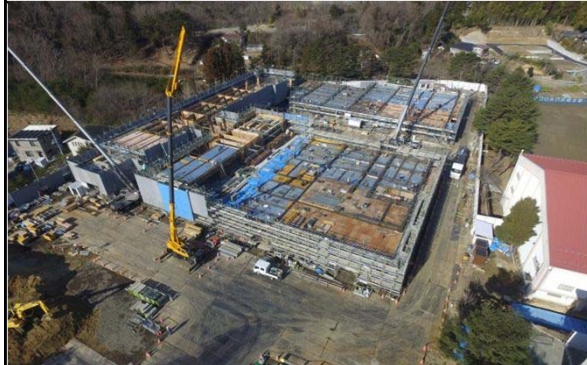
老朽化学学校施設の改築 （平成29年2月 現在 躯体 施工中）
