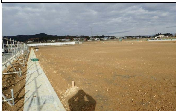
気仙沼向洋高校舎新築工事 気仙沼市長磯牧通地内（平成28年9月 着工）
