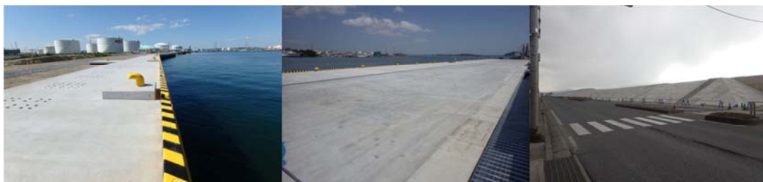
仙台港区・栄地区
