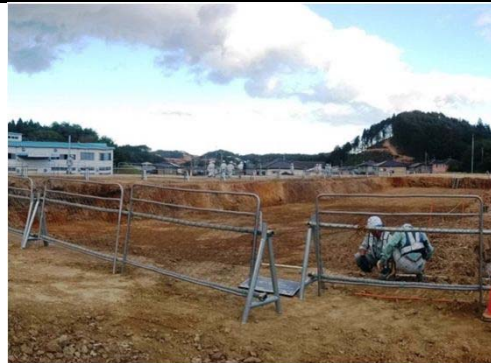
平成27年9月5日 着工
