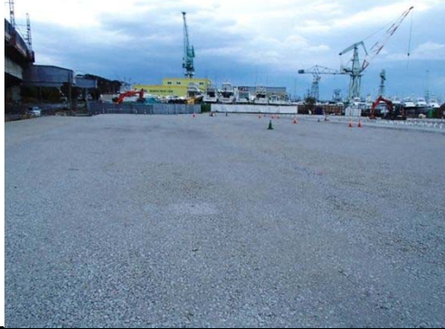
平成27年9月5日 着工 北浜地区災害公営住宅 塩竈市
