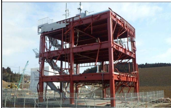
津波被災庁舎の改修（震災遺構化検討用） 平成29年2月 完成
