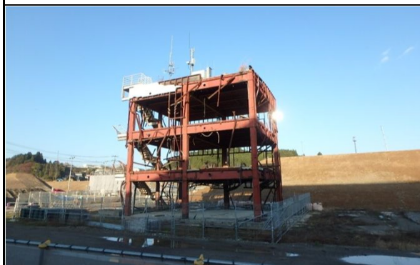
南三陸町旧防災対策庁舎改修工事 南三陸町志津川字塩入地内（平成28年10月 着工）
