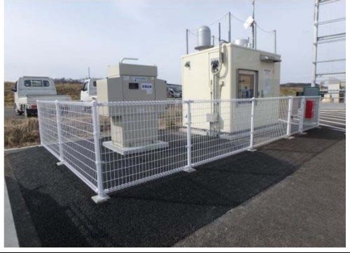
平成29年2月28日 完成 発電設備設置後
