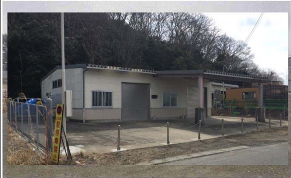
津波被災学校施設の改修 （平成28年5月 完成（復旧完了））
